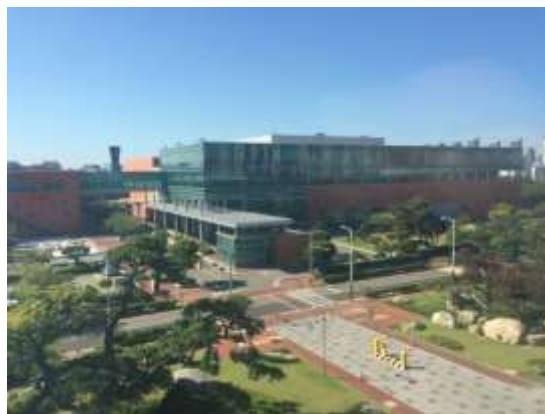
Celltrion 二期廠房外觀
