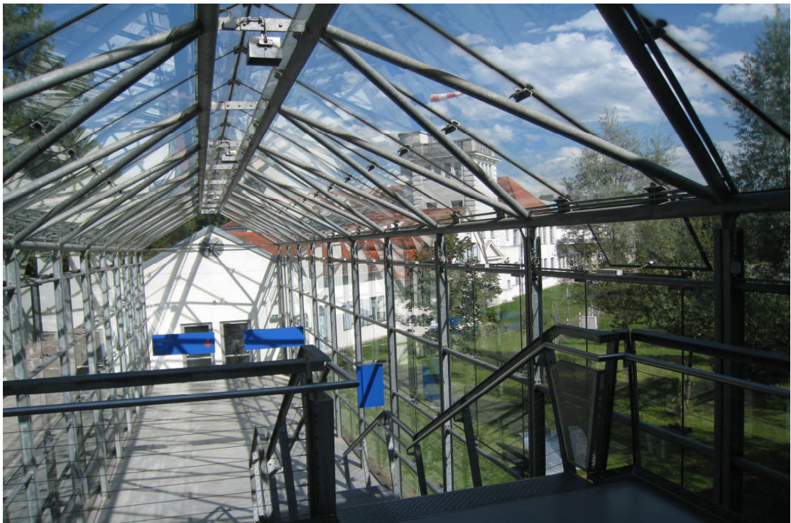
圖十八 建築物連接使用玻璃
