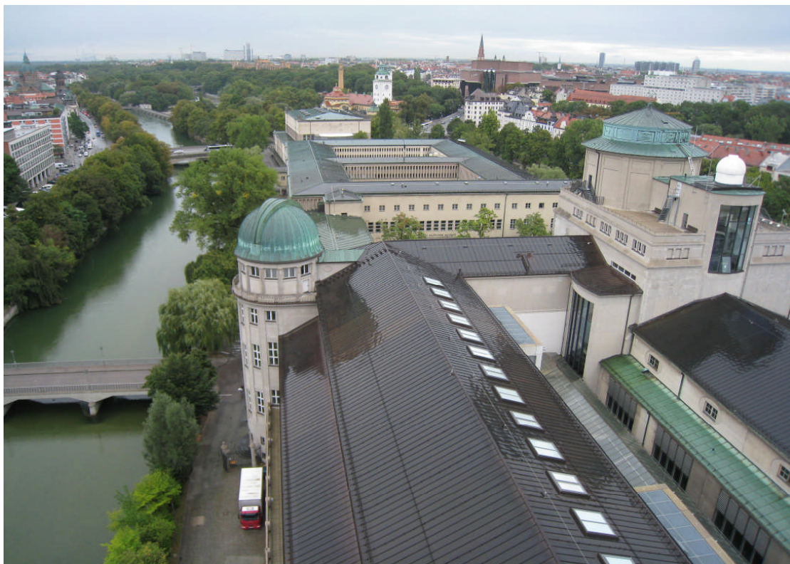
圖二十一 屋頂爲銅製材料
