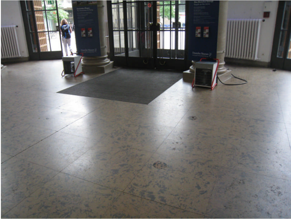
圖十七 主要出入口暖氣設備
