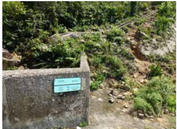
萬宜水庫內斜坡登記標誌
