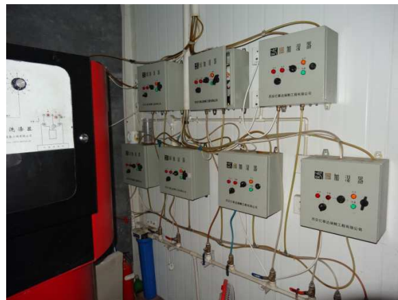
冷藏庫之加濕控制系統
