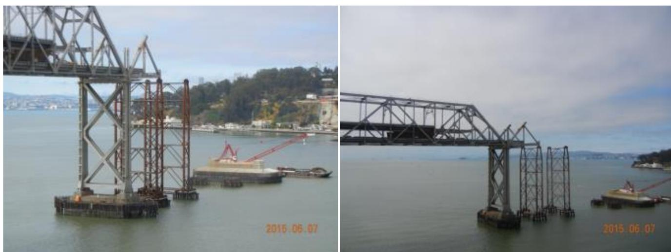
海灣大橋舊橋拆除-利用臨時支撐及浮船吊車拆除
