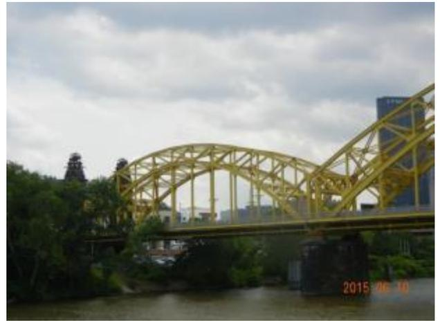
橋面板利用鋼承板，結構上大量的使用眼桿(eye bar)，可見早期的結構工程師純化拉力桿件的應用，以類似懸索橋的理念，利用在橋梁懸吊結構上，眼桿可視為 hinge 的利用。
