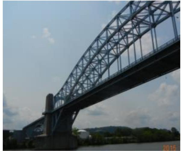
本橋使用拱及桁架結構，引道的立柱為利用桁架及繫板設計，特別的是主跨的拱原理應用，基礎部份仍模擬為鉸支承。
