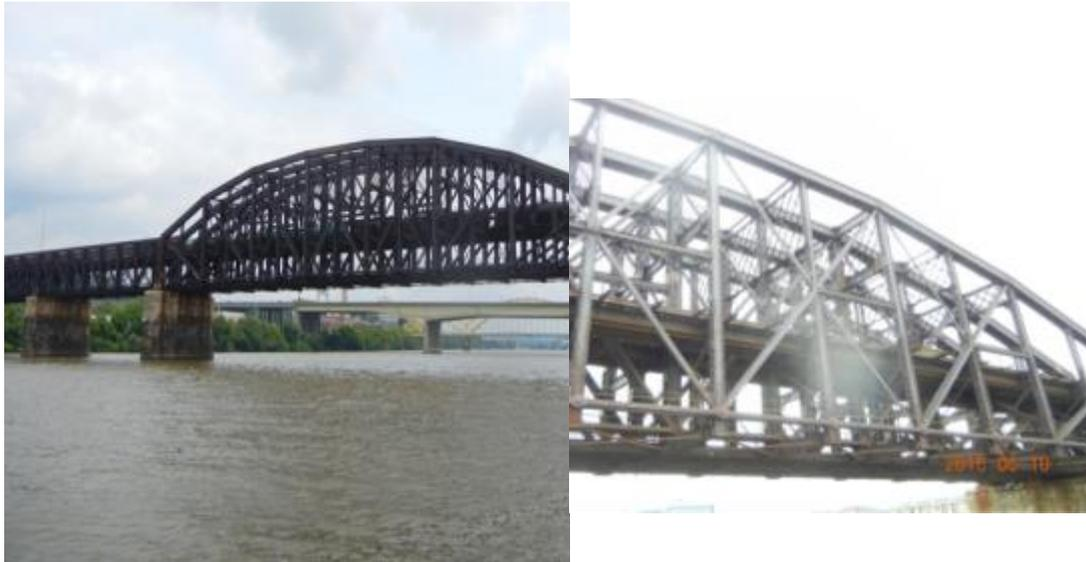
結構上大量的使用眼桿(eye bar)、繫條與繫板，利用鉚釘做為連結，由於早期型鋼尺寸的限制，多半利用繫條製作組合式大型鋼構件。可見結構設計師應用力學的巧思，尤其是桁架節點，全採用 pin 接來模擬二力桿行為。
