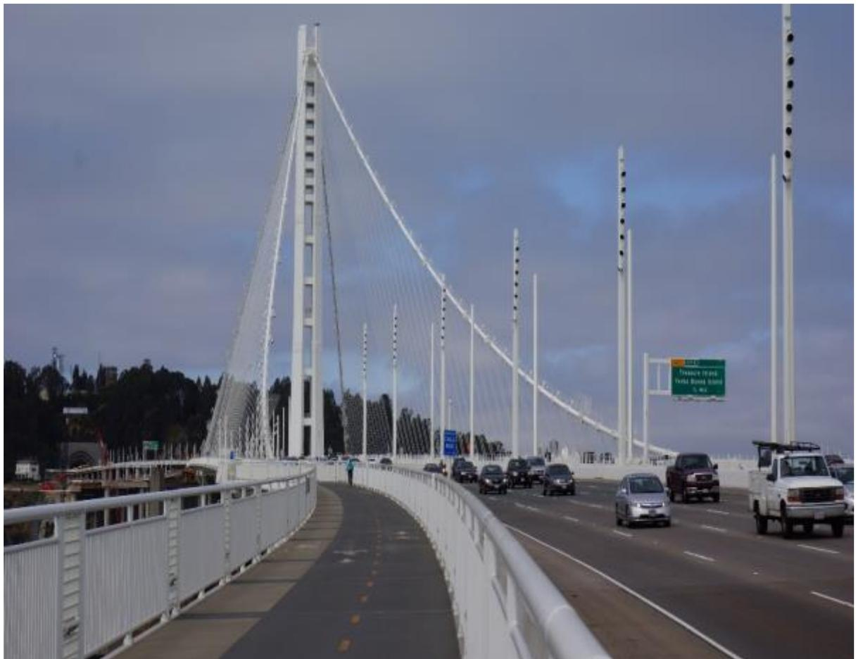
Bay Bridge(San Francisco)於橋側設有人行、自行車道，可供人員及自行車通行，於路側設有簡單植栽，為了確保安全，外側為人行步道，內側則為各 15.5 英尺寬的雙向自行車道，目前僅開放部分時段通行，本次參訪過程係以步行方式由入口處步行至新橋橋塔處，步行其上雖主線車流眾多車速亦快但未感覺到橋梁明顯震動，步行其間會有自行車通行惟數量不多，在設計橋梁時同時考慮到行人及自行車的需求，在現在綠色運輸的趨勢下，這種設計理念值得參考。
