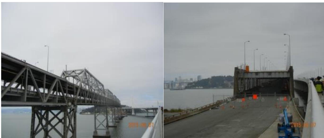
可能受限於當時的煉鋼技術，所以舊港灣大橋仍使用繫板、繫條所構成立柱的複合結構，觀察梁與斜撐間之連接板(Gusset Plate)，可見其設計上仍注意其傳力路徑。
