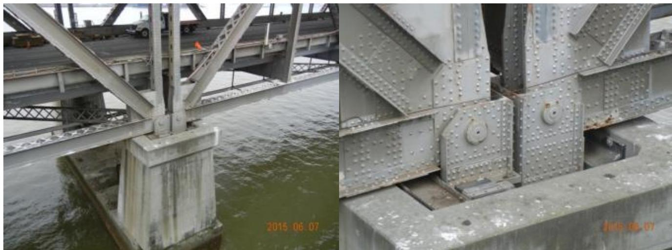
下圖為當年地震發生落橋的地點，係為兩種桁架型式結構的接合跨，一般長跨的橋跨，多半是受風力控制，但該地點落橋的原因是震落，從後來修復的結構來看，已經加設了防落橋裝置。
