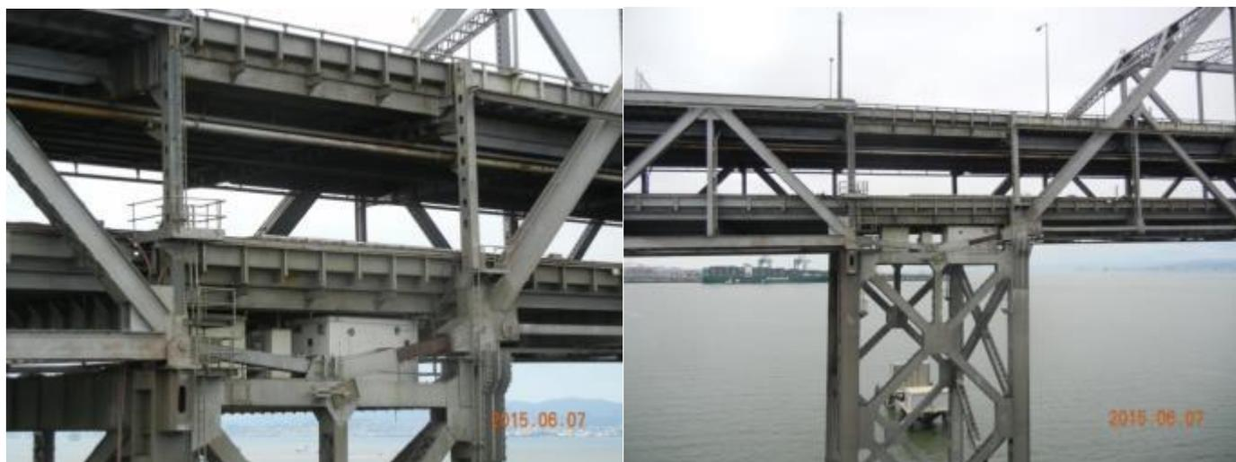
當地政府已經開始小心的拆除東半部的舊橋，長達兩英哩的橋跨將採分節分階段反序拆除，亦即依當初 1930 年代興建本橋的順序逆向拆除，拆除將分為三階段於 5 年內完成，所拆除之鋼筋超過 58,000 噸、混凝土超過 245,000 噸。
