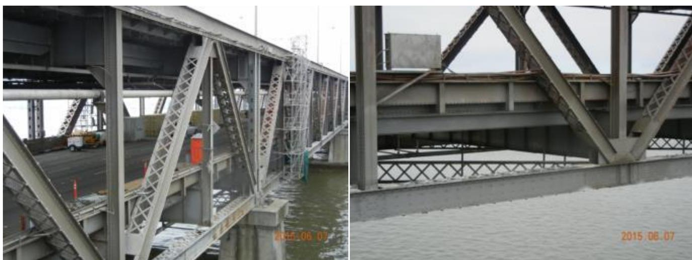
舊橋的基礎為混凝土澆置，設計為樁基礎，當時使用的是木樁，桁架端點使用的是鉸支承。
