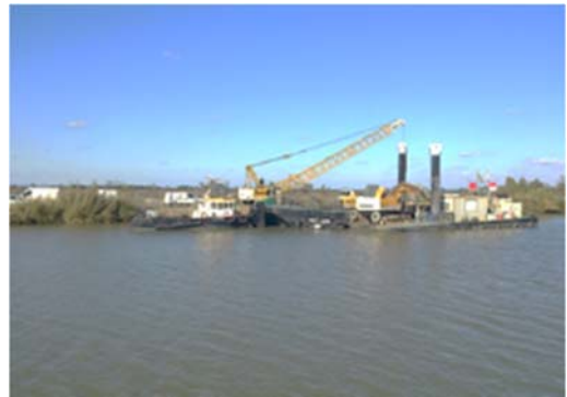
河道上施工的挖泥船及平台船
