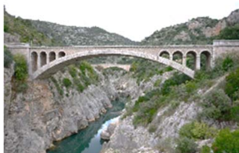
埃霍河上的新橋及水道橋
