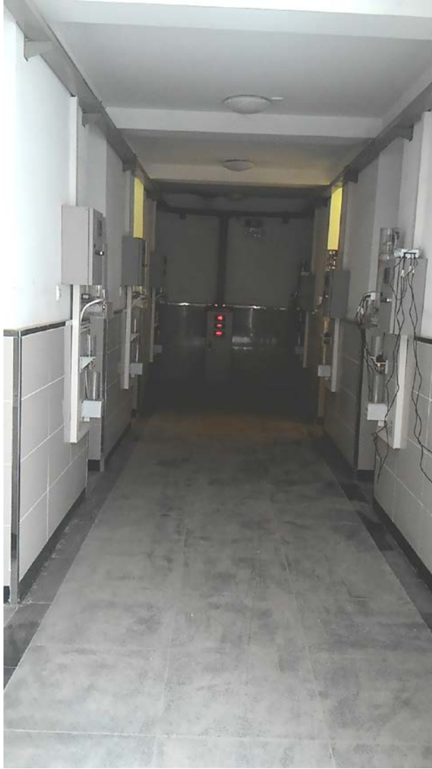
圖 8 地底土壤實驗室均設立不同土壤之監測儀器
