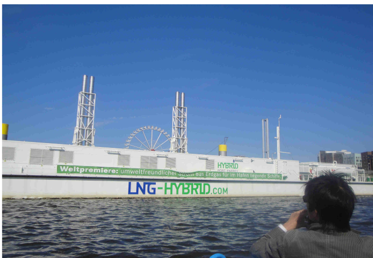
LNG 供電駁船
