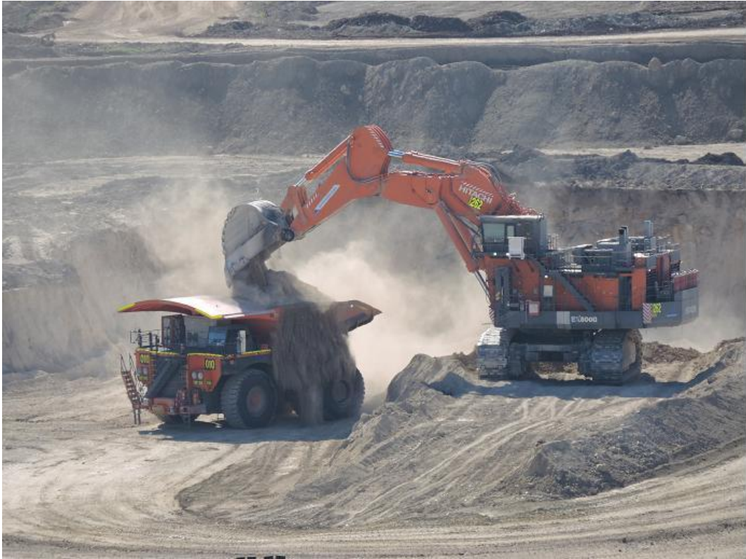
圖124 Maules Creek礦區覆土移除作業
