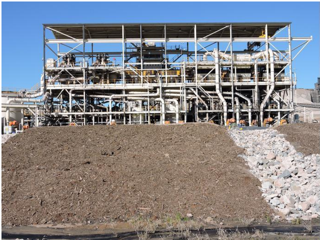
圖135 Maules Creek 礦區CHPP
