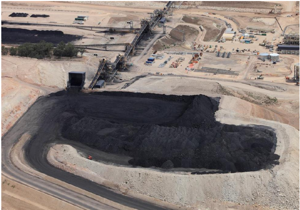
圖117 Maules Creek煤礦原煤儲存場
