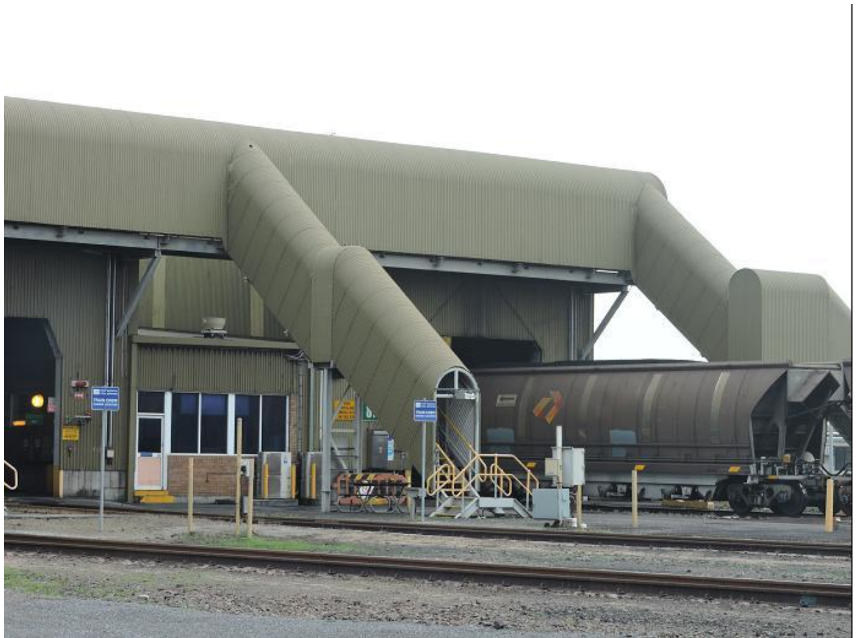
圖145 PWCS 火車卸煤站
