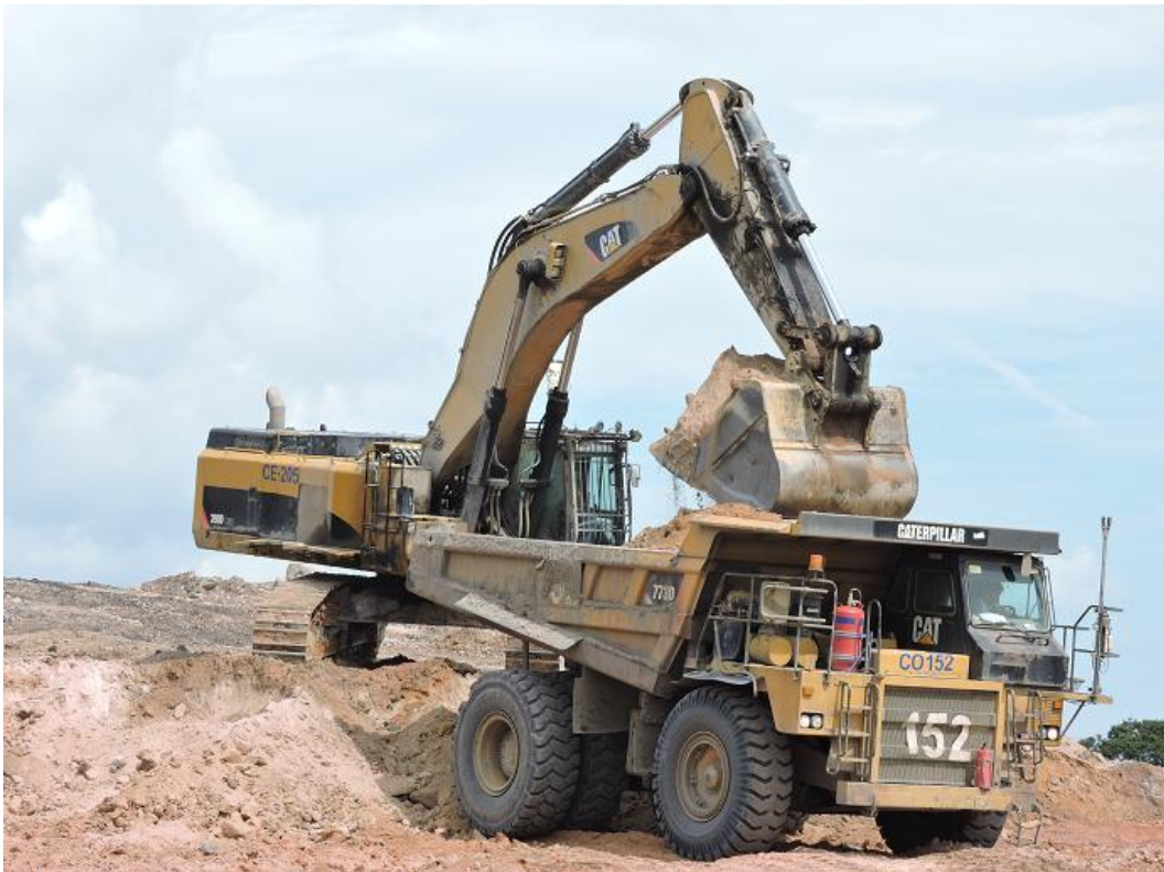
圖77 Kaltim Jaya Bara礦區移除覆土
