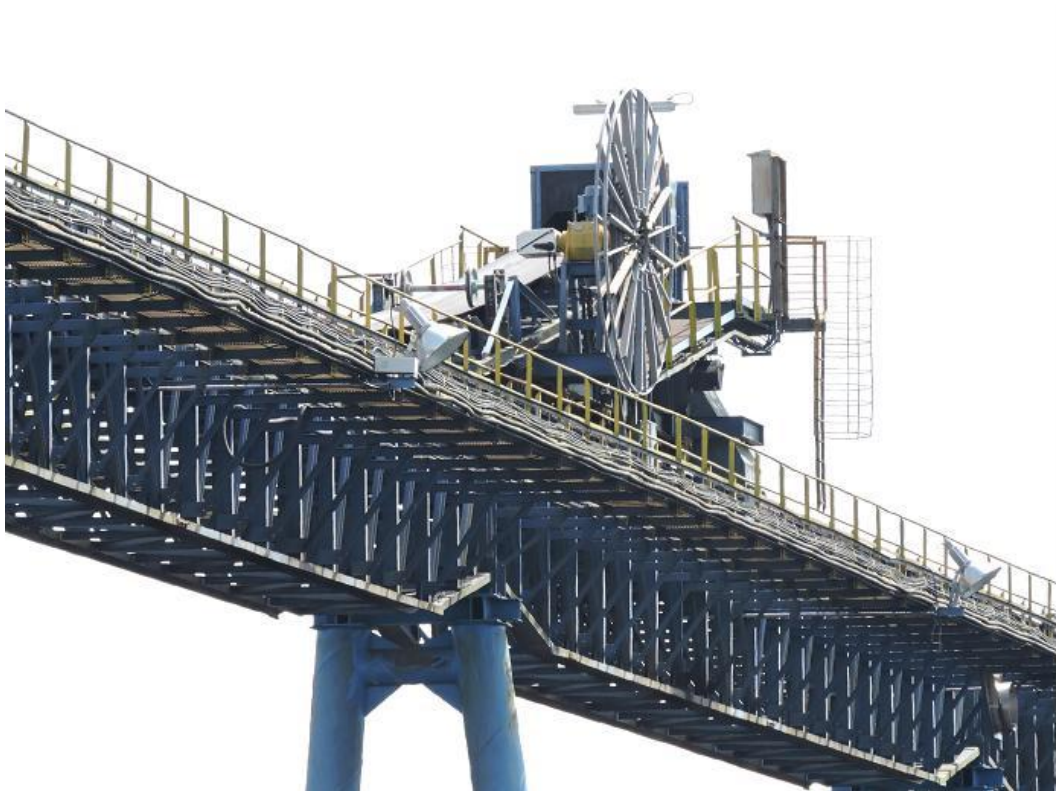
圖32 產品煤儲煤場之堆煤機
