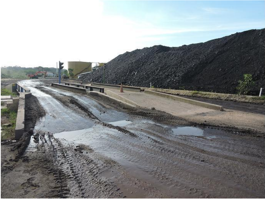
圖80 Lebanan Jetty原煤儲煤場入口之地磅
