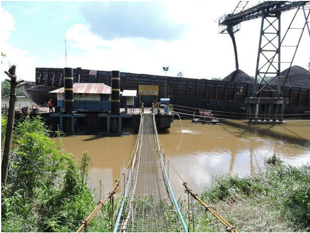
圖39 Muara Bunyut Jetty
