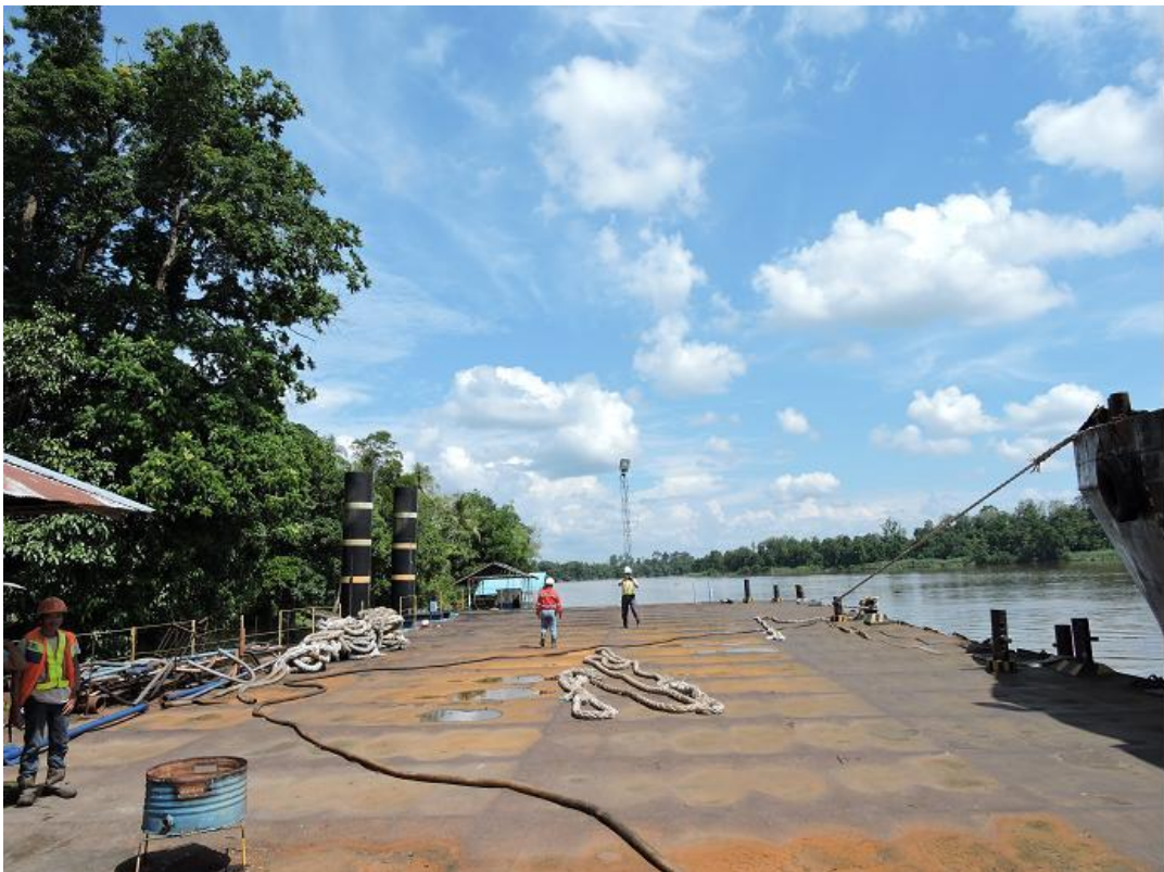
圖40 Muara Bunyut Jetty
