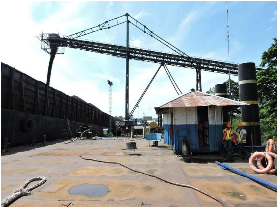
圖41 Muara Bunyut Jetty
