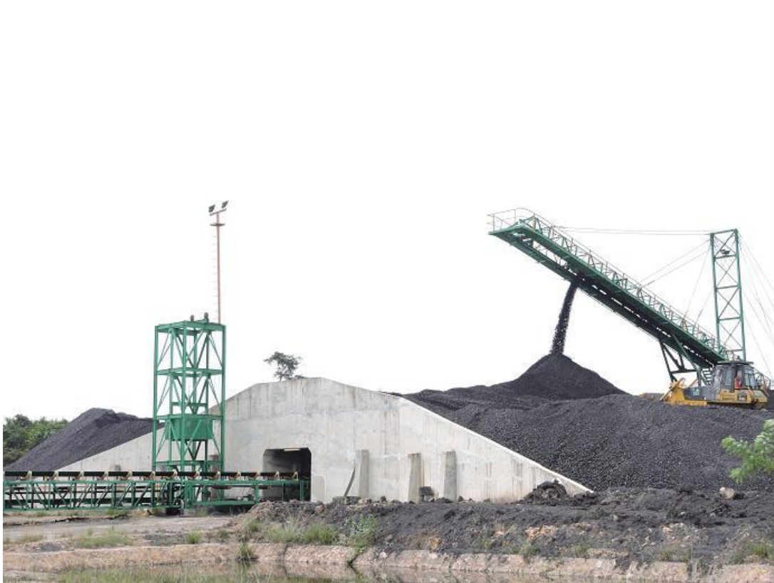
圖85 Kaltim Jaya Bara礦區儲煤場及輸送帶
