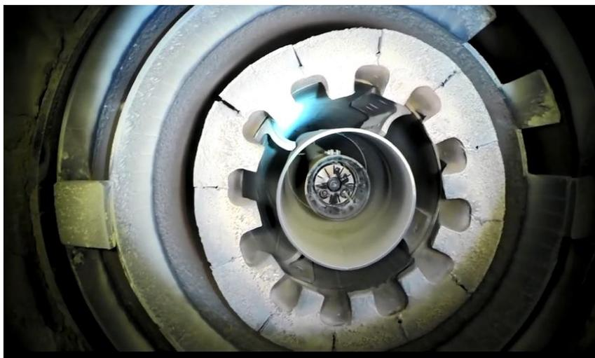
圖 2.41 燃燒器檢視遙控飛行器檢視影像
