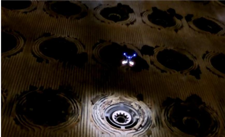
圖 2.39 燃燒器檢視遙控飛行器檢視中
