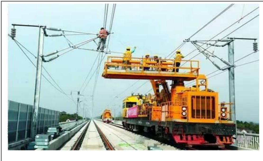
圖 4.2-3 電車線工程施工
