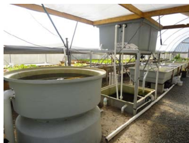
圖 20 系統循環水導入植栽槽
