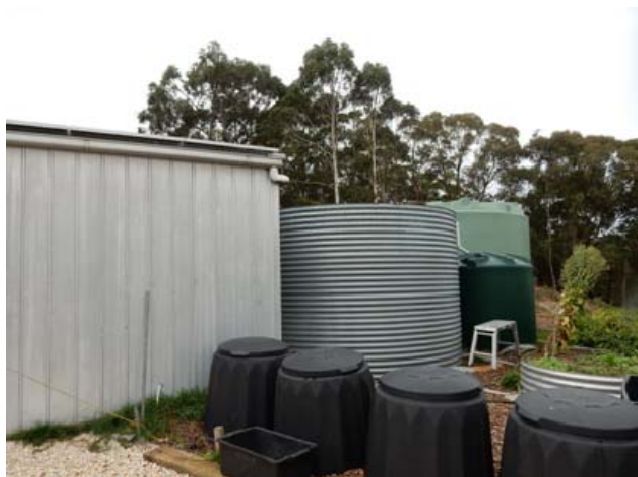
圖 7 堆肥處理桶(前)及雨水回收槽(後)
