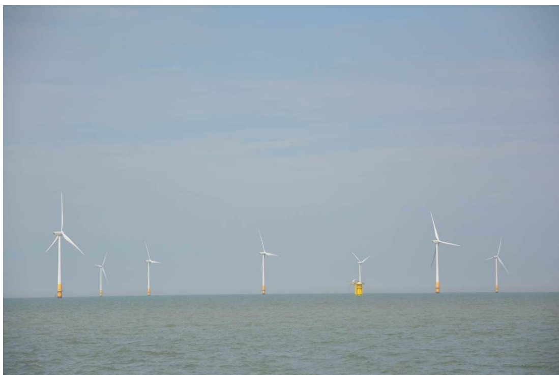
圖 23、Kentish Flats Extension 離岸風場
