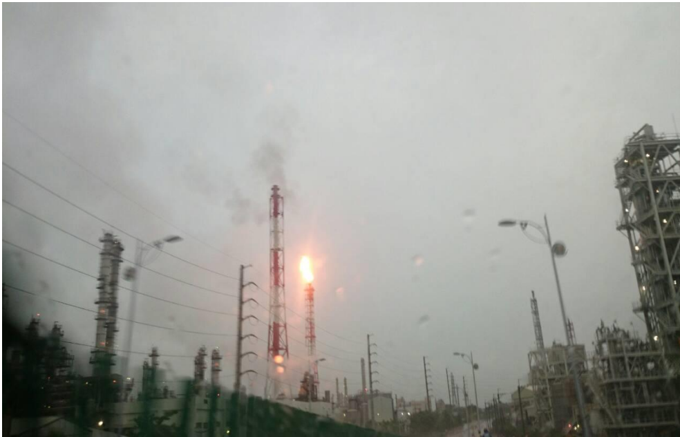
圖 4. 104 年 5 月 24 日因製程異常跳車，導致 Flare 排放情形。
