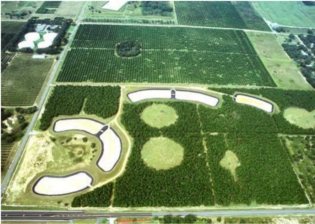
圖 26 Water Conserv II RIB Site 4 空中鳥瞰情形
