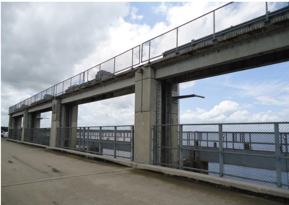
圖 21 羅德曼水壩溢洪道閘門
