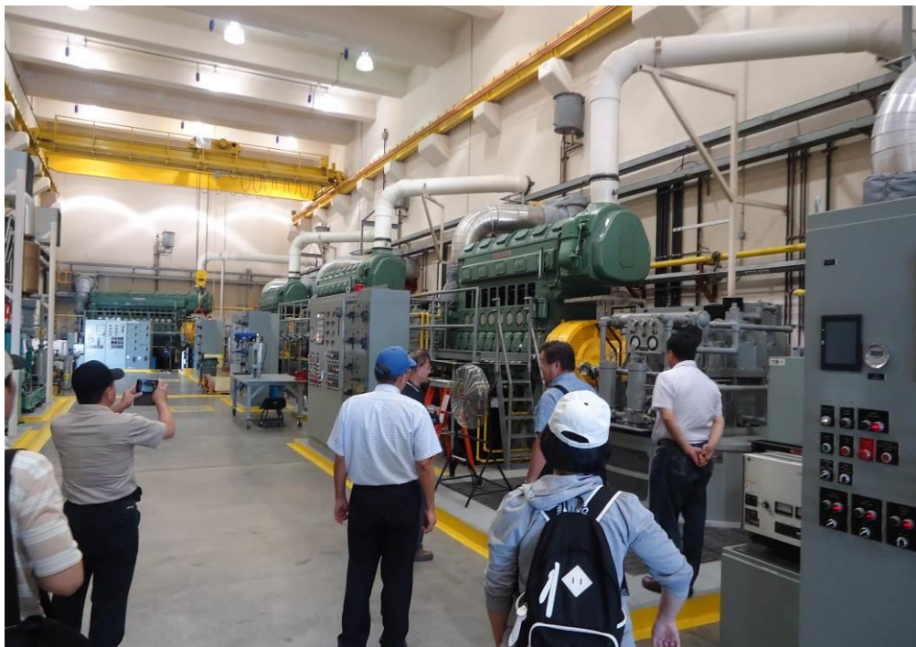
圖 38 S-319 抽水站現地觀摩情形
