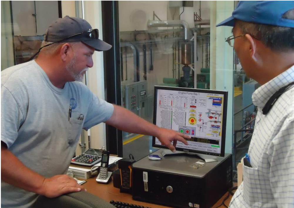
圖 39 S-319 抽水站控制室
