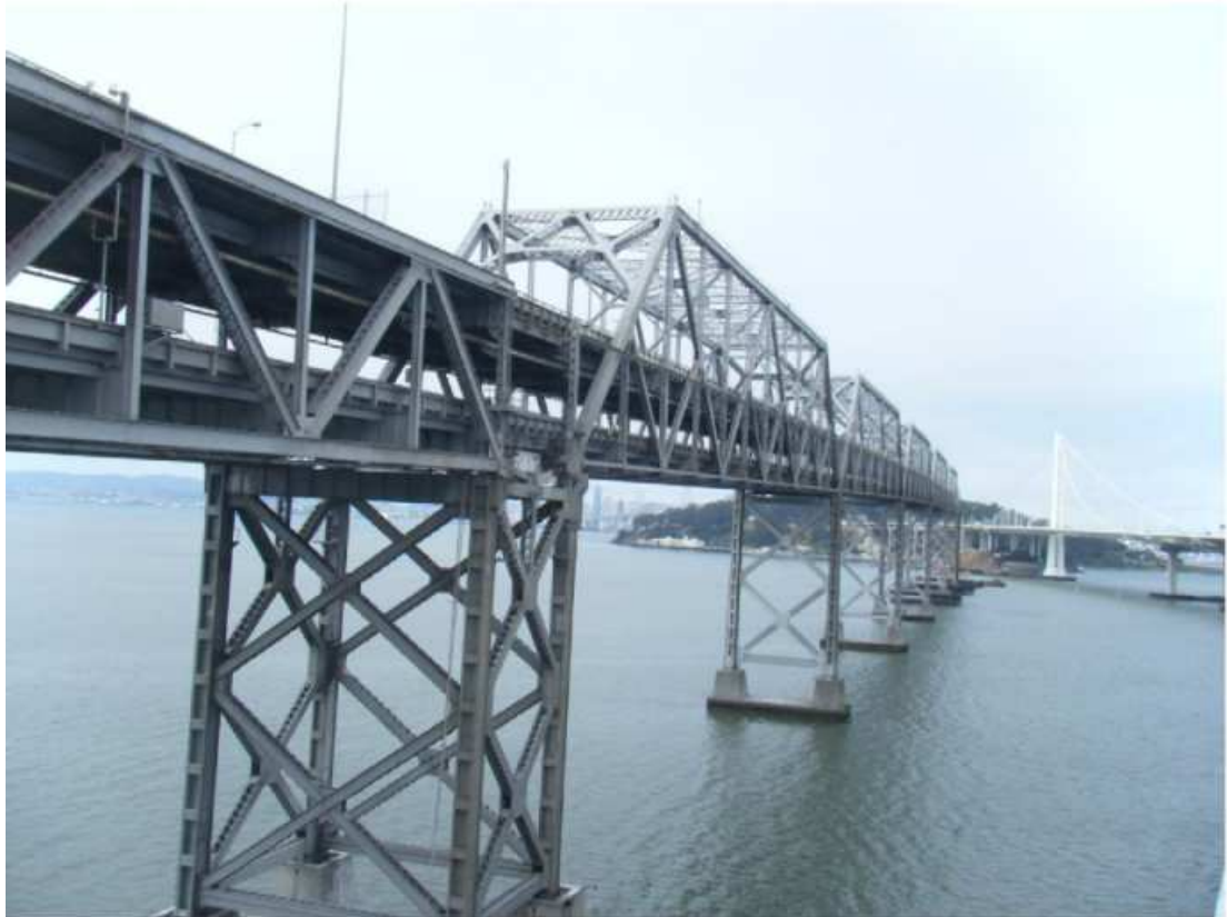
圖 5.8 尚未完成拆除港灣大橋近照
