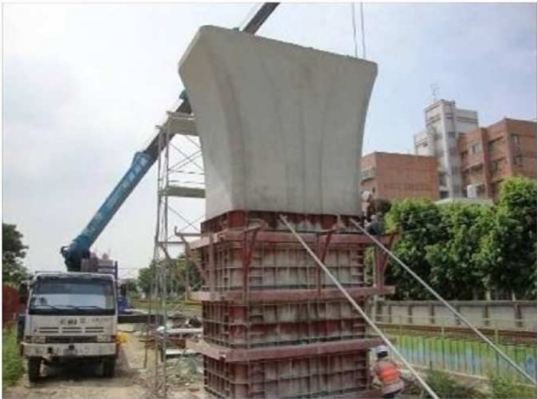
圖 3.22 橋墩鋼模拆除中
