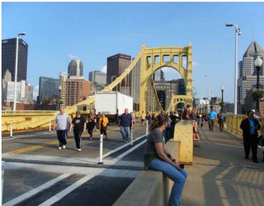
圖 5.29 橋梁封閉，僅供行人通行
