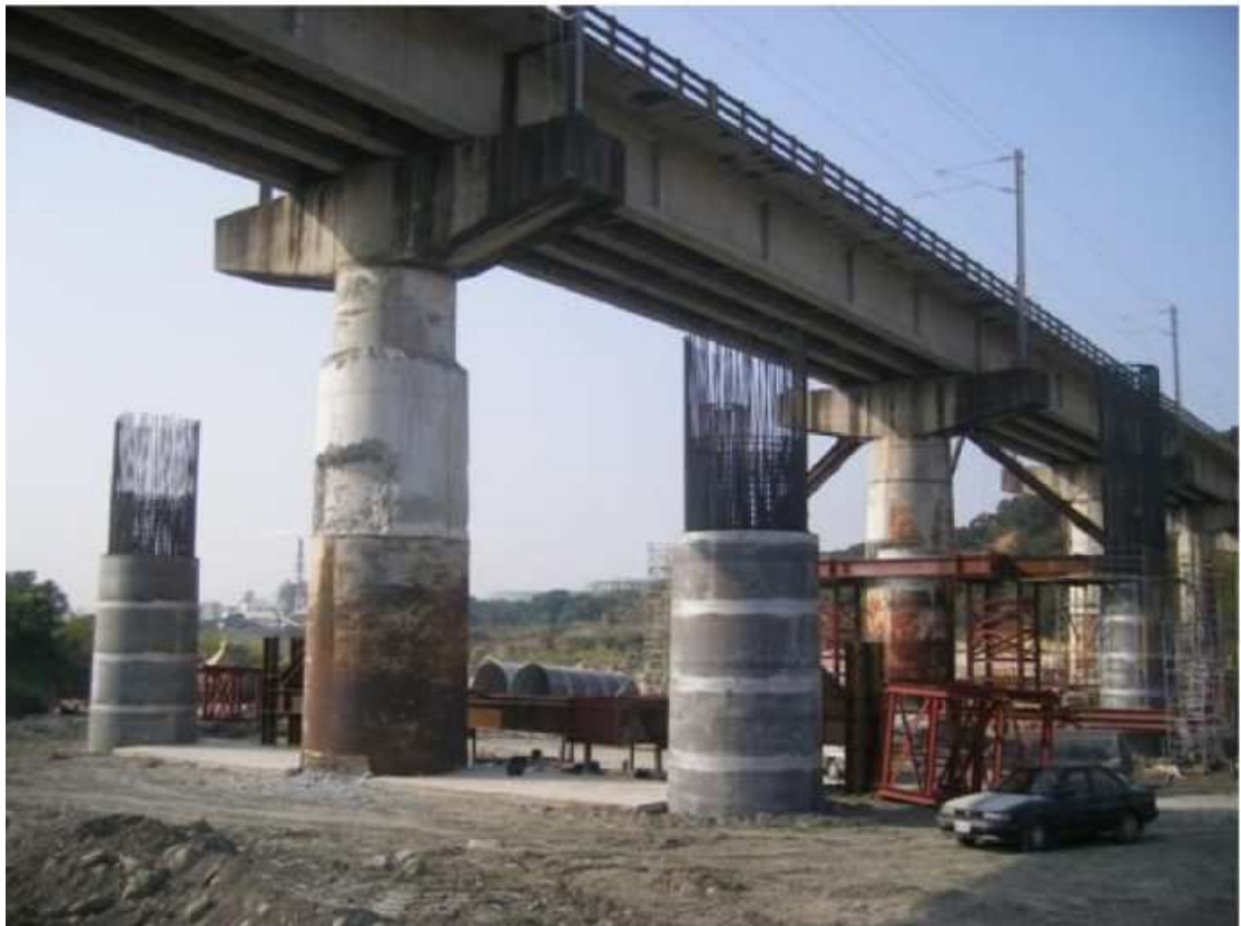
圖 3.14 大甲溪橋新建兩側橋墩
