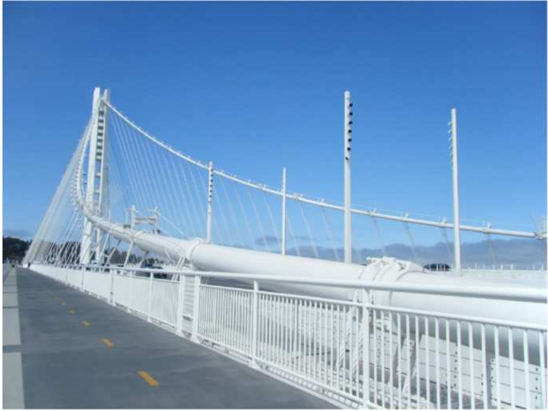
圖 5.4 高聳的鋼纜橋柱
