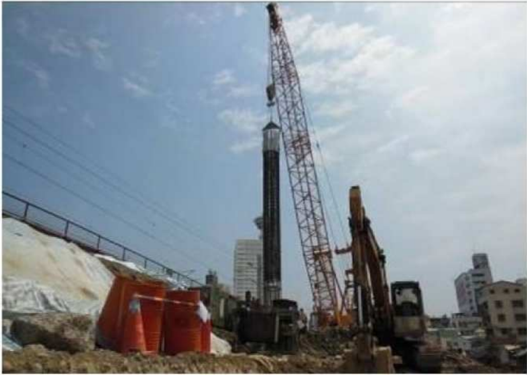
圖 3.21 基樁鋼筋吊裝
