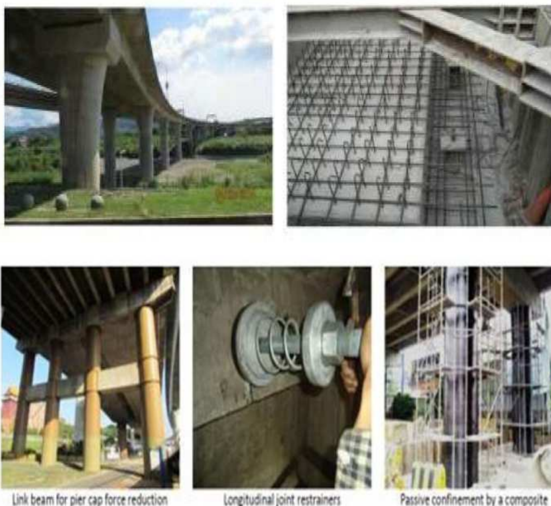
圖 3.28-1 國道高速公路橋梁耐震補強措施 (一)
