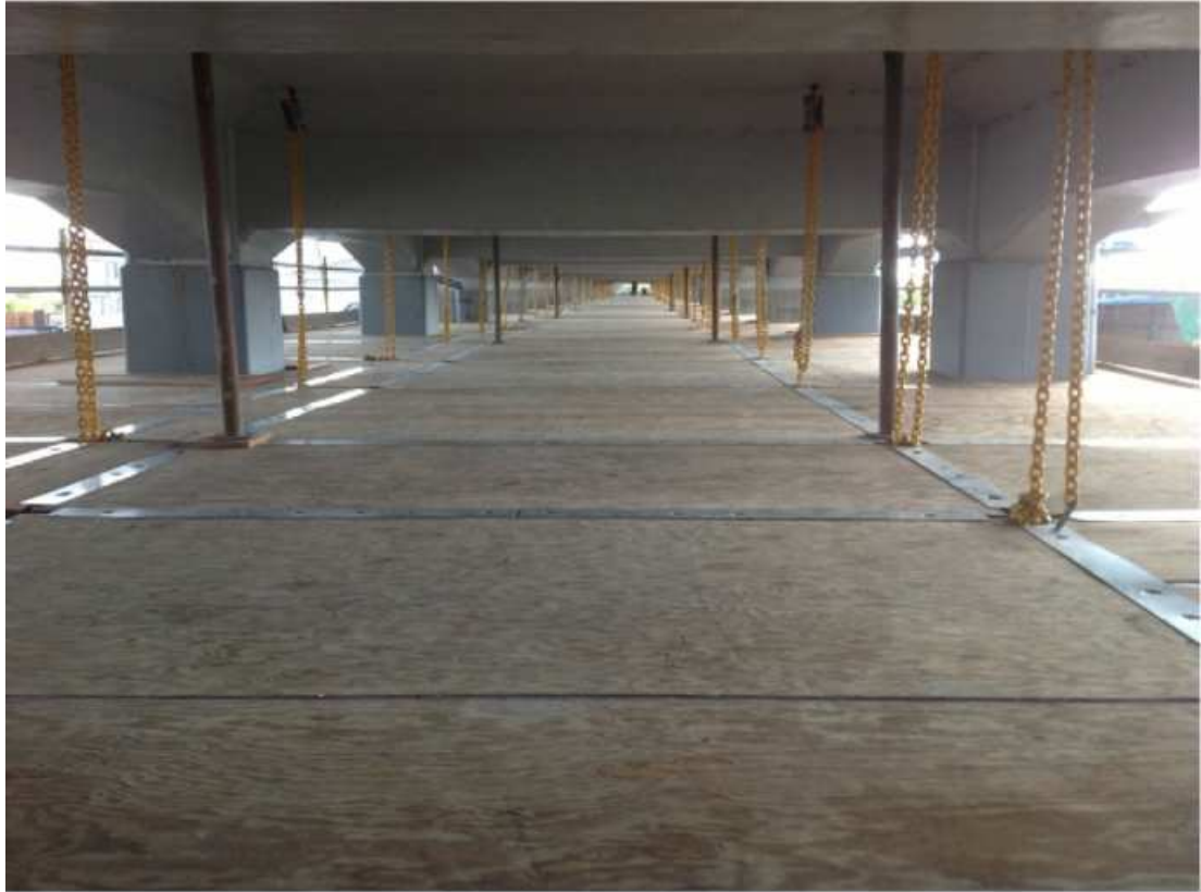
圖 4.2 Quick Deck 架設於橋梁下方
