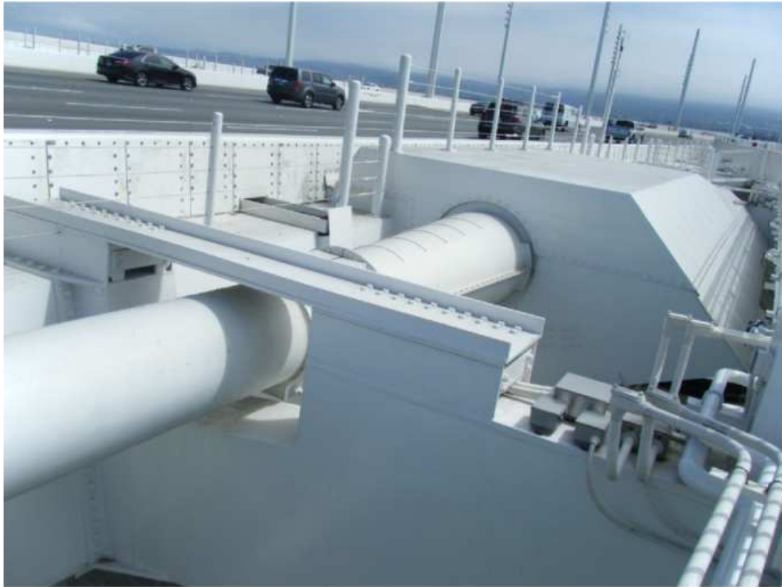
圖 5.6 新港灣大橋鋼纜錨碇座
