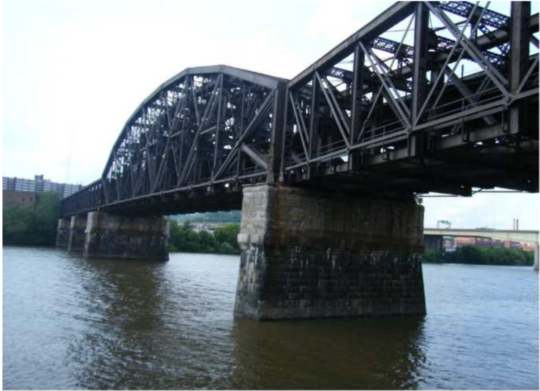
圖 5.23 位於會議中心壯觀的雙層鐵路鋼橋
