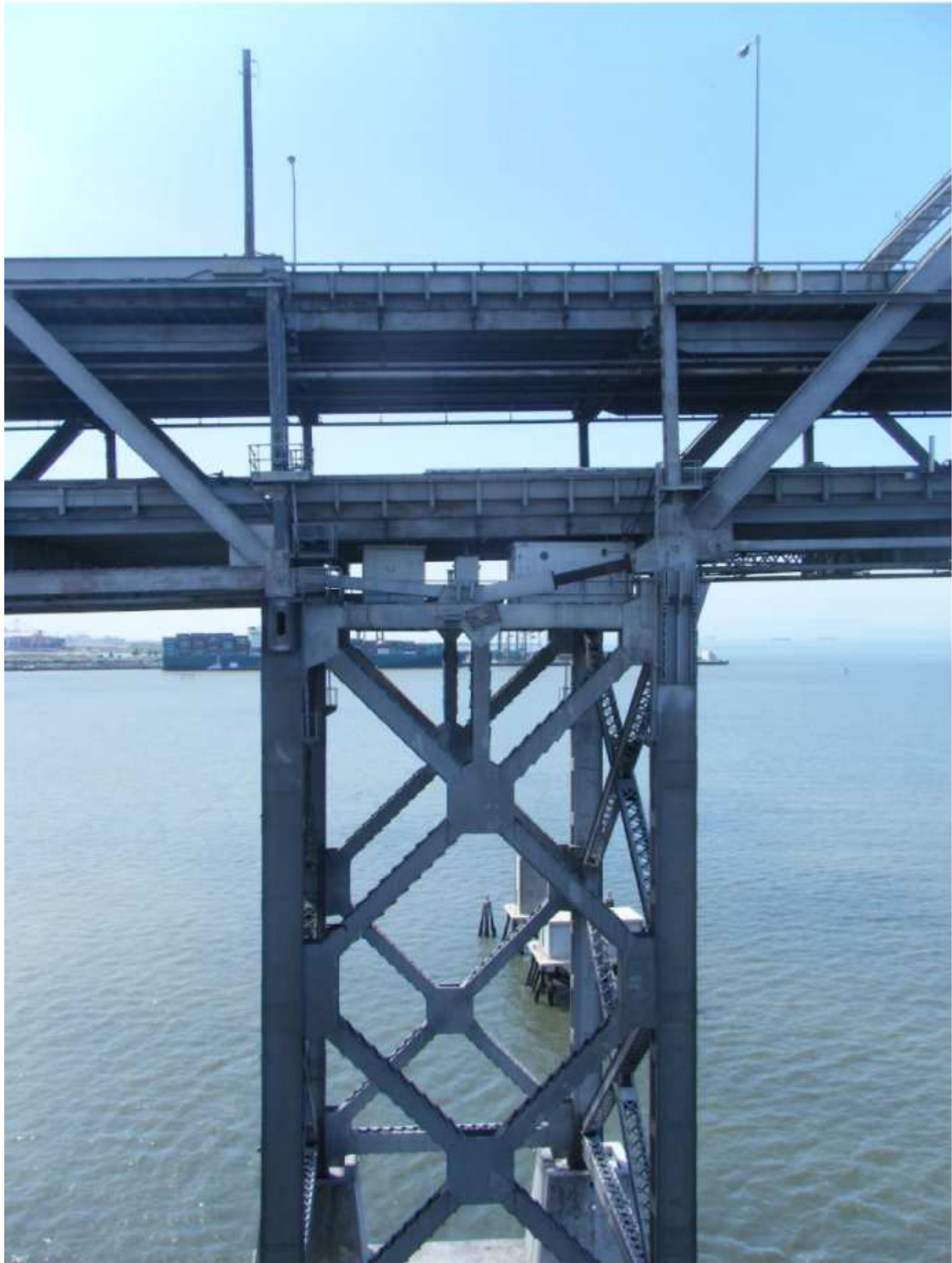
圖 5.2 舊港灣大橋的鋼結構橋墩
