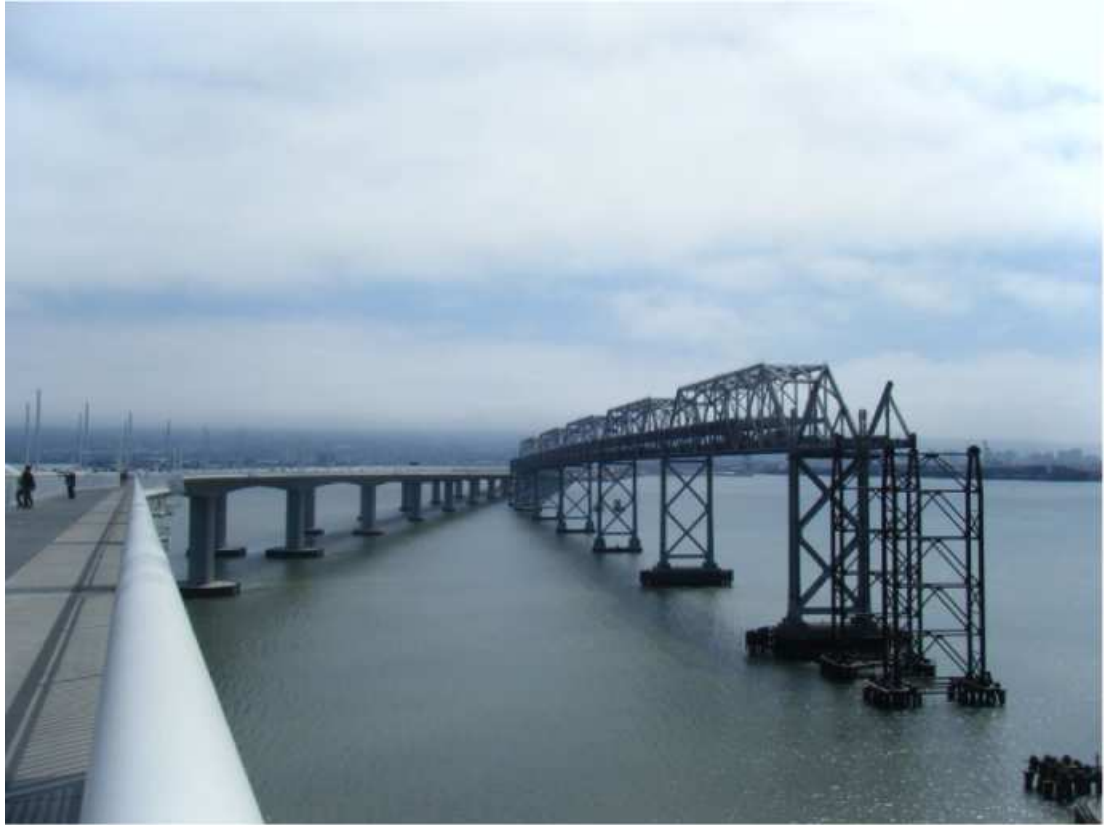
圖 5.7 舊港灣大橋正逐步拆除中
