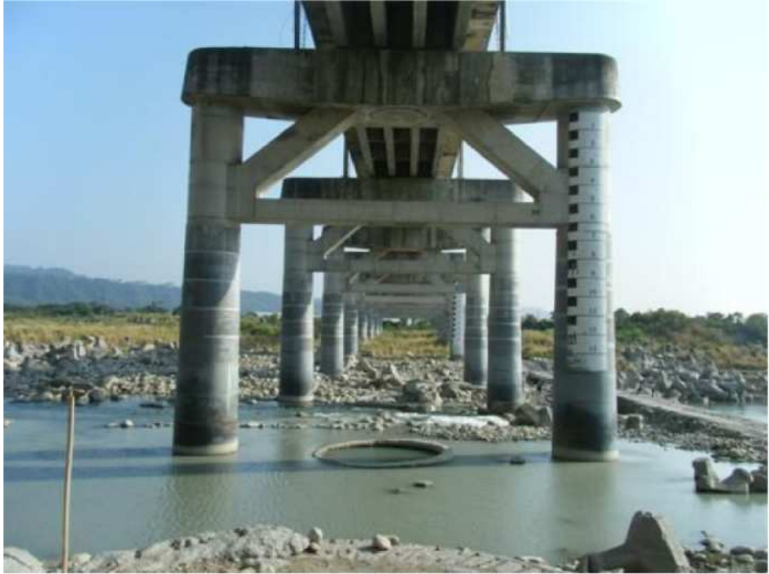
圖 3.15 換底工法完成後照片
