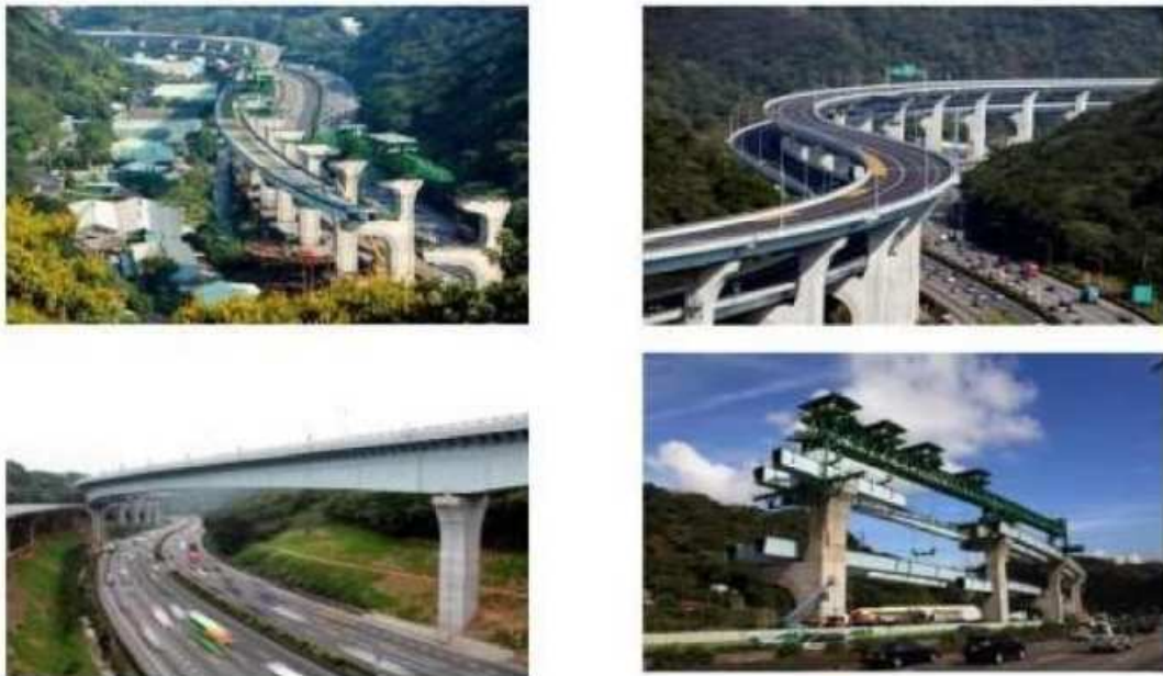
圖 3.23 泰山~林口間施工照片
