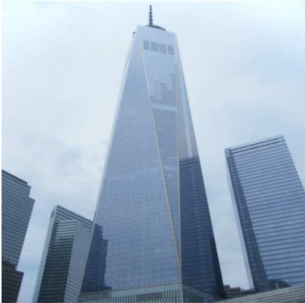
圖 5.32 新世貿中心於 2013 年 11 月完成，72 層樓高度 541 公尺為美國最高
