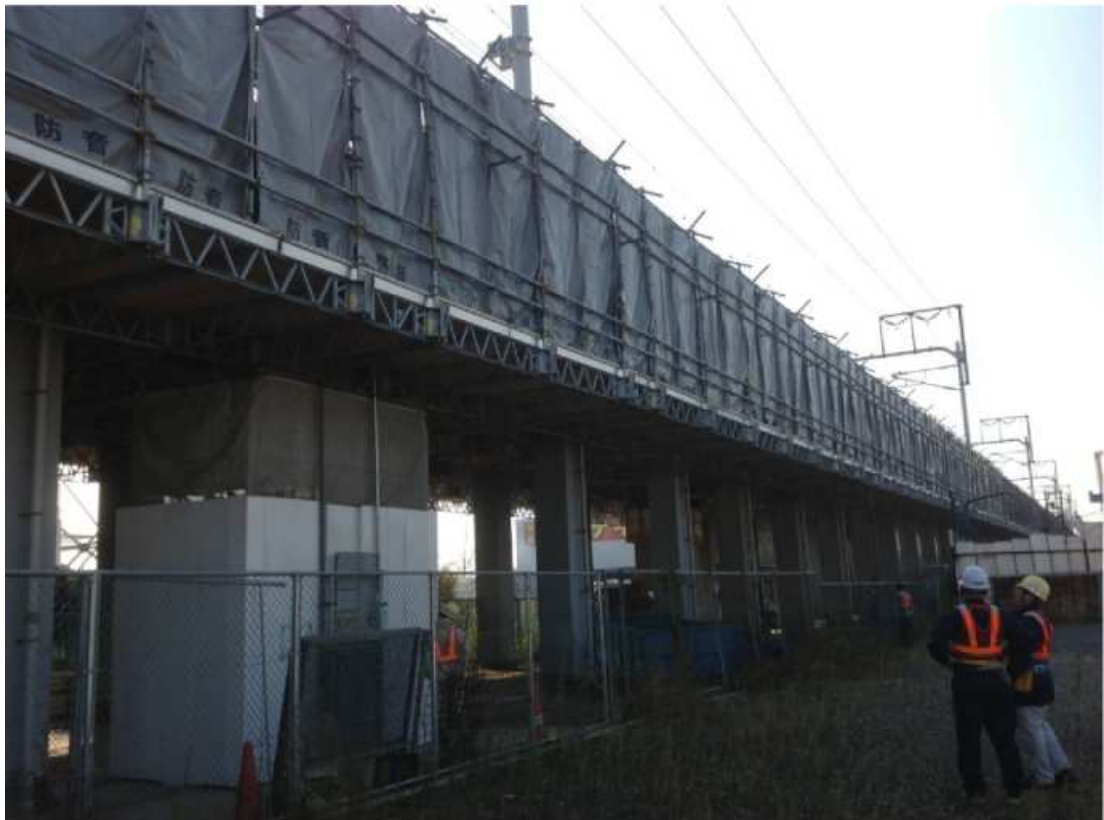
圖 4.3 Quick Deck 架設於橋梁下方於日本鐵路橋架設完成外觀
