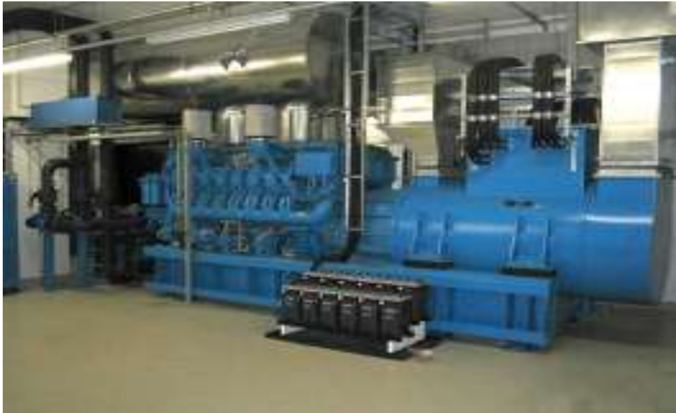
柴油動態式(飛輪式)UPS
