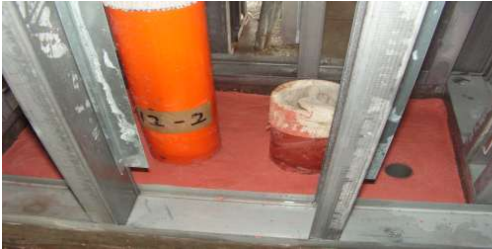
管道間防火填塞
