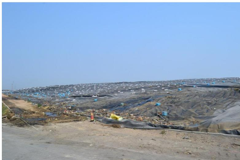
圖 2.4.5 小澗西固體廢棄物掩埋場最終掩埋面鋪設不透水布
