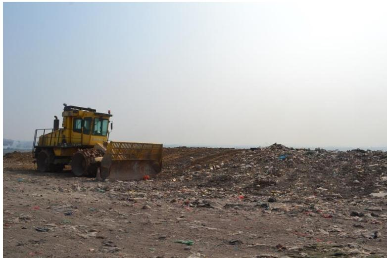
圖 2.4.4 小澗西固體廢棄物掩埋場掩埋作業
