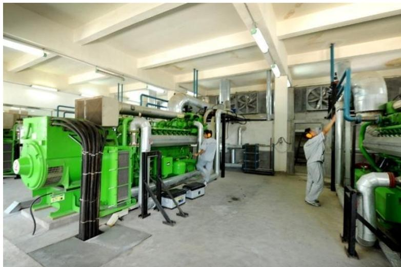
圖 2.2.8 發電機組(3 百萬瓦 MW)
