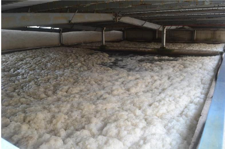
圖 2.6.4 污水進入曝氣生物濾池進行生物處理情形
