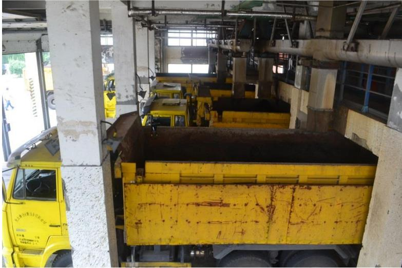
圖 2.6.10 脫水污泥直接裝載於卡車
