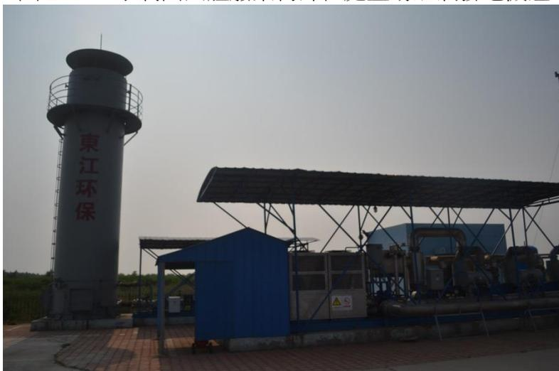
圖 2.4.8 小澗西固體廢棄物綜合處置場沼氣純化設備
