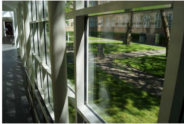
圖 5-8 走道間採雙層玻璃減低室內溫濕度變化
