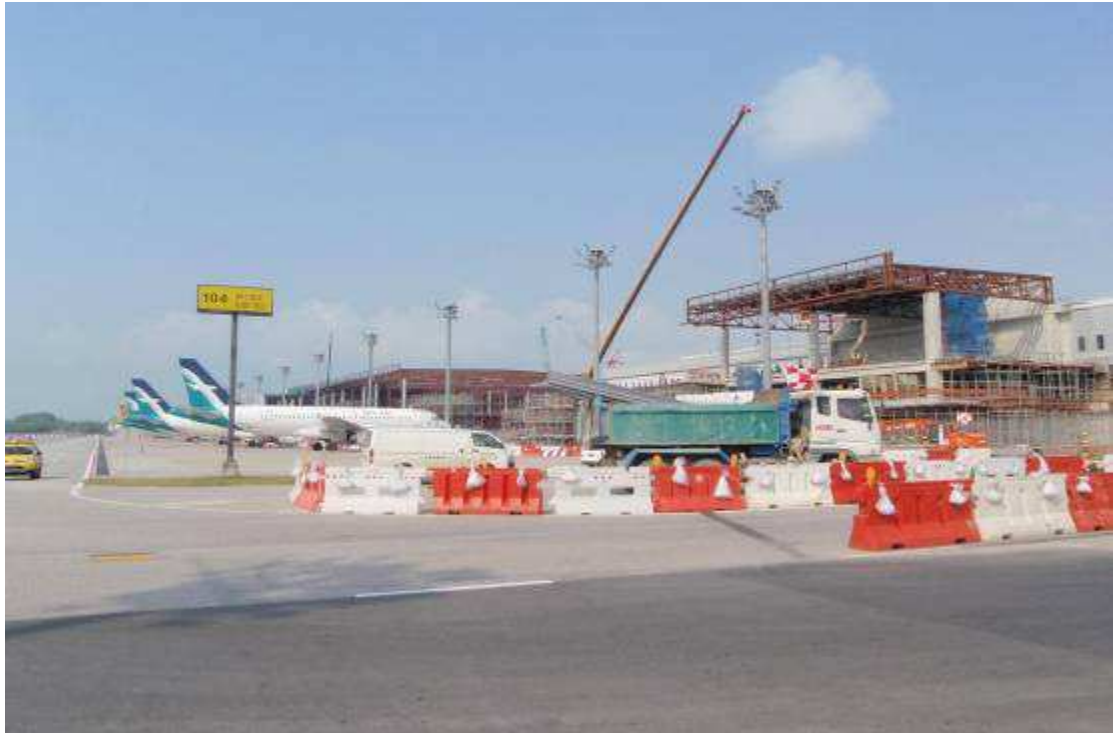
圖 17： 施工中的第四航廈及其阻絕防護設施
