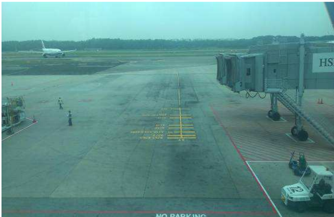
圖 15：客運停機位停止線及空橋操作區禁制標線
