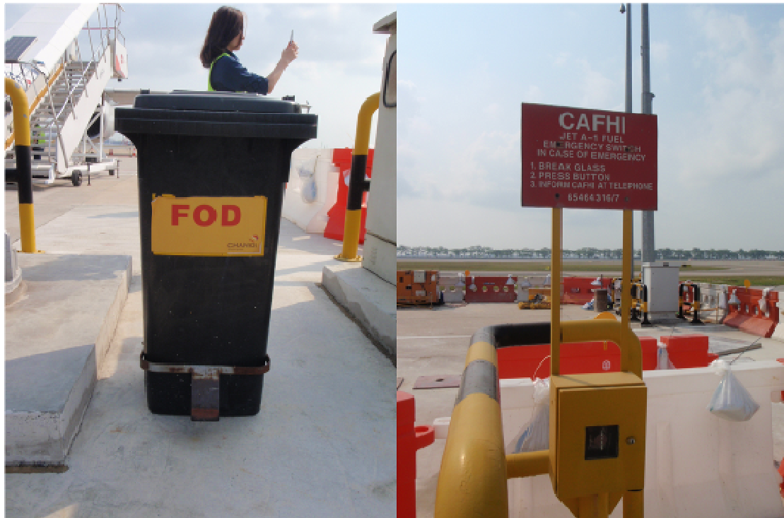
圖 13：FOD 棄置桶及緊急停油開關
