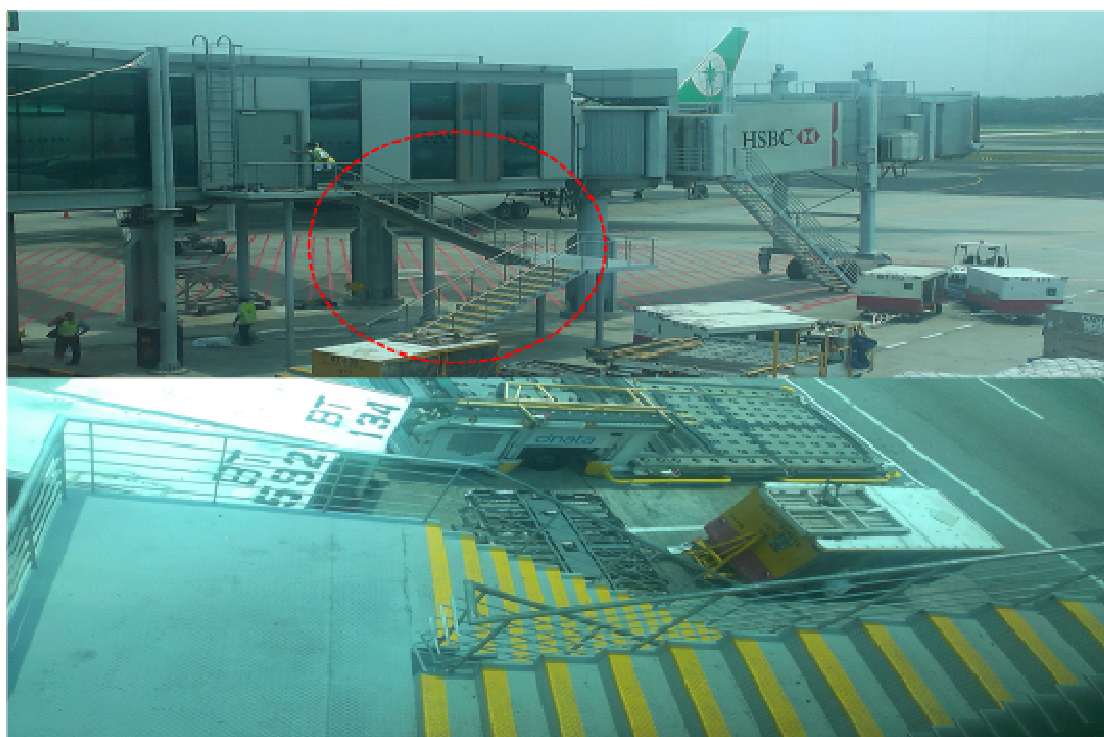
圖 22： 固定端空橋便梯安全警示標記
