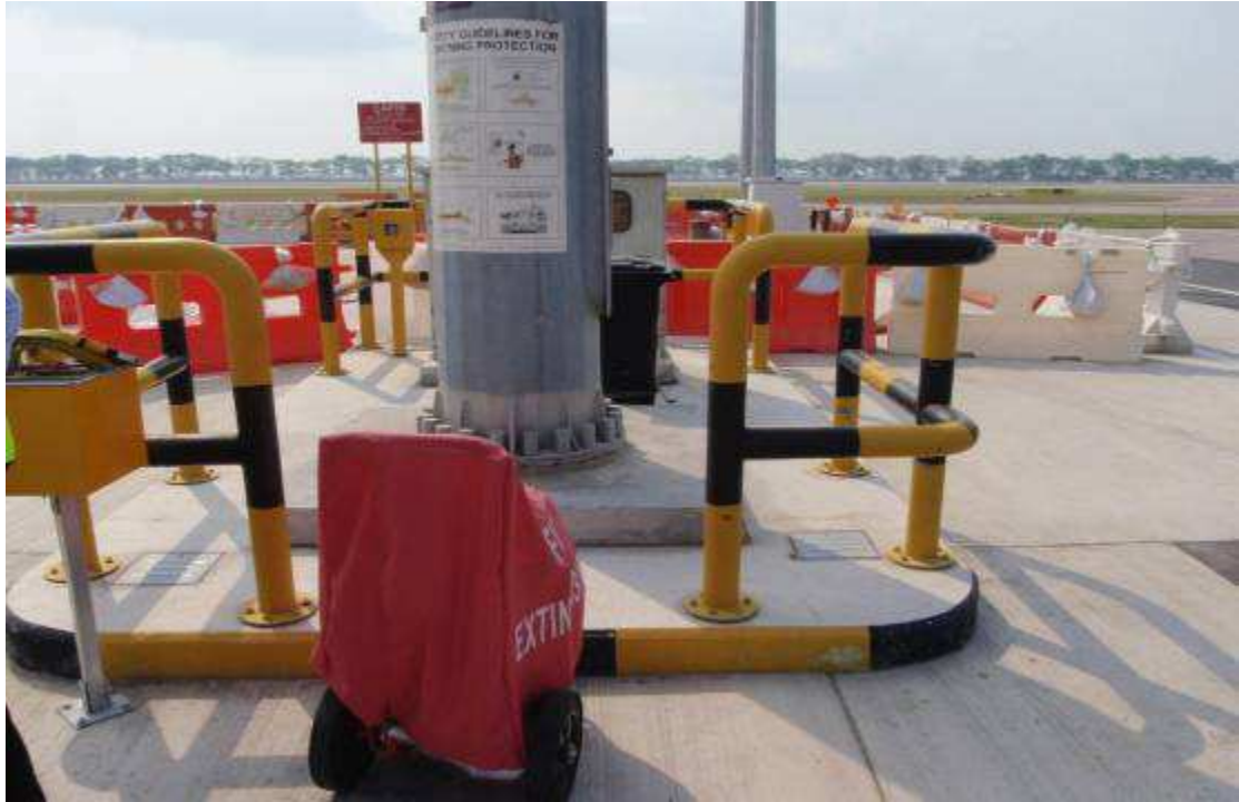
圖 10：遠端機坪投光燈柱保護設施及相關設備
