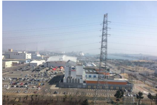
仙台港地區現況
