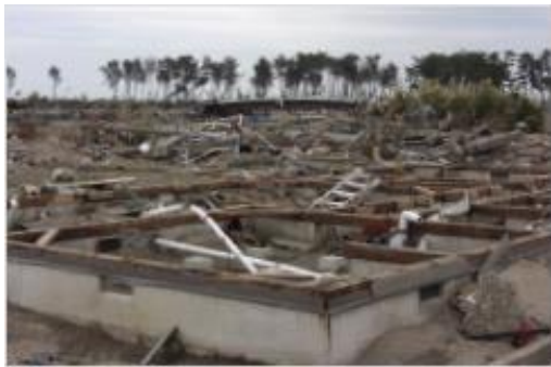
海嘯過後只剩下房屋基礎
