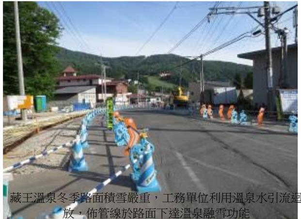
藏王溫泉冬季路面積雪嚴重，工務單位利用溫泉水引流迴放，佈管線於路面下達溫泉融雪功能
