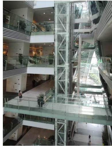
圖書館建築中間結構
