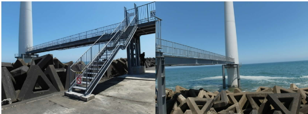
圖 24：神栖近岸風場風機與岸邊通連之天橋
