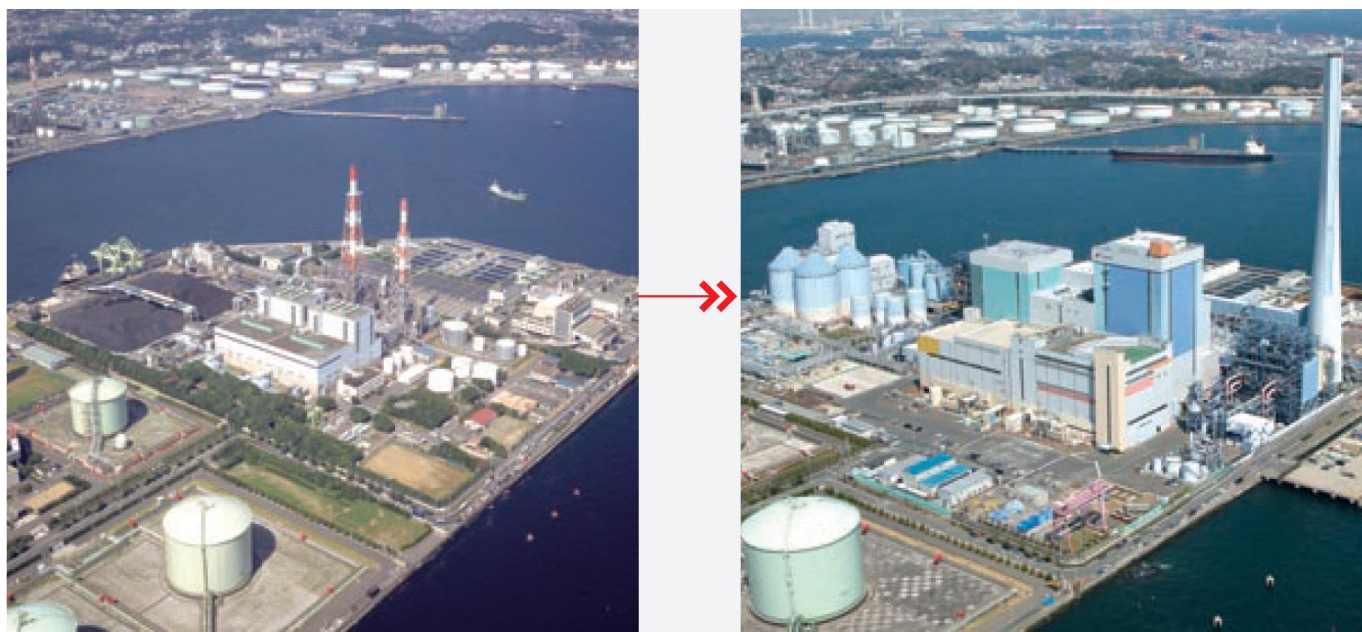
圖 14 磯子火力發電廠改建前後之外觀
