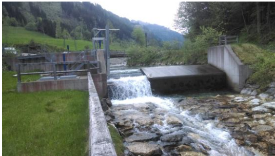
Photo.7 Sunkbach 電廠攔河堰及進水口
