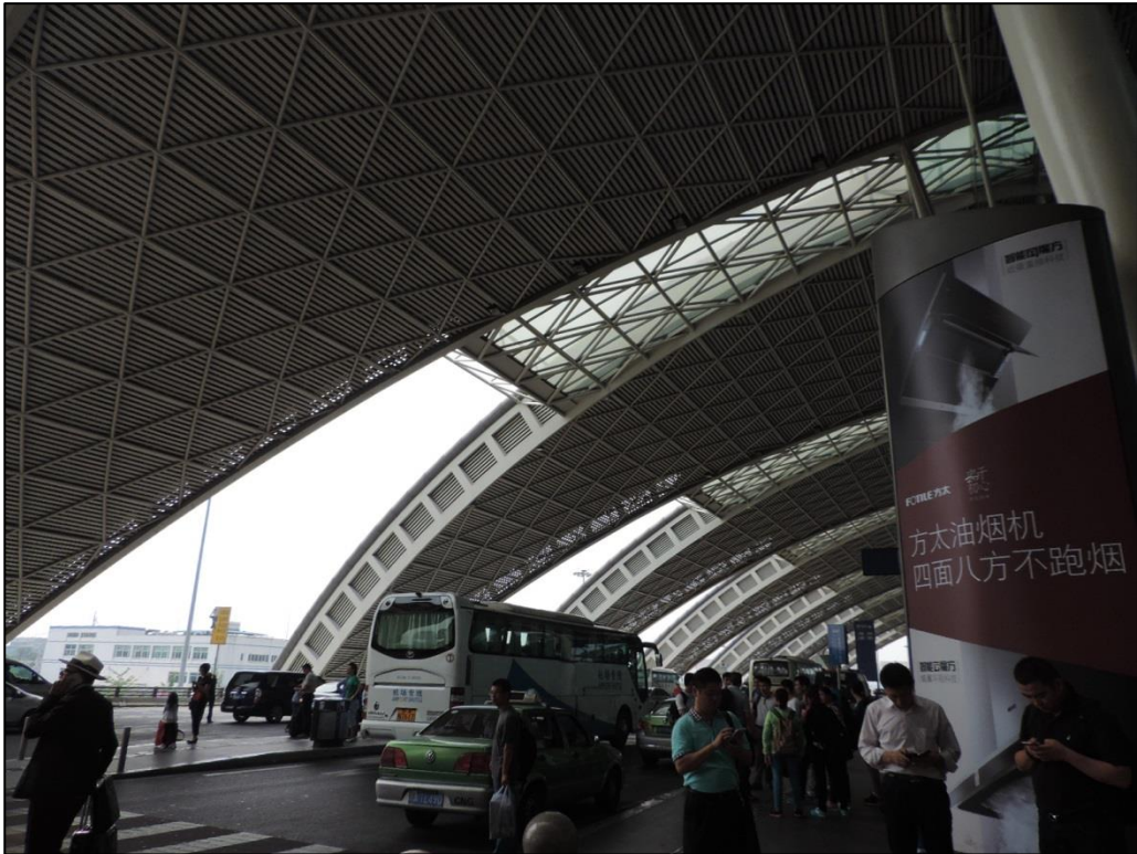
圖 23、出境層路緣的遊覽車、小客車、計程車混雜，交通非常混亂
