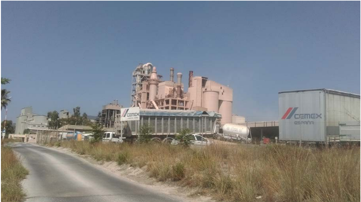
照片25 蒂莎水泥公司布尼奧爾廠道路入口
