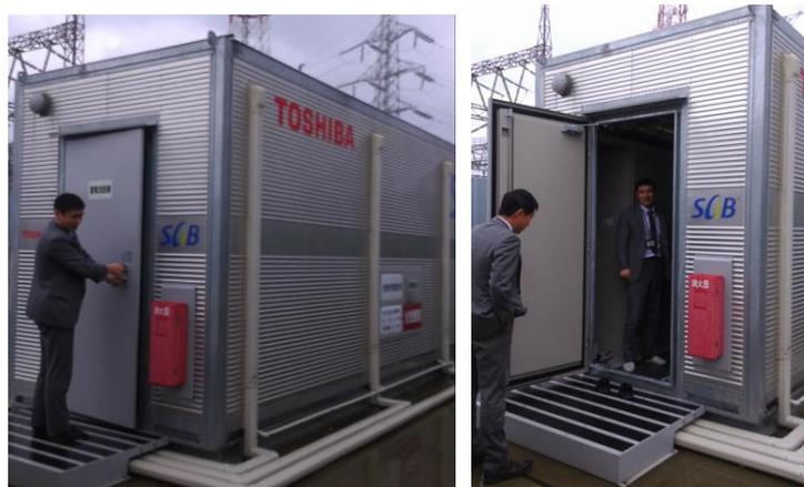
照片 2. 東京電力網島變電站 TOSHIBA 300 KW SCIB 儲能電池
