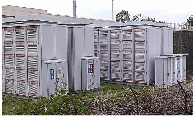
照片 5. 8MW NAS 儲能系統 (2MWX4 PANEL，50 KWX40 MODULE)
