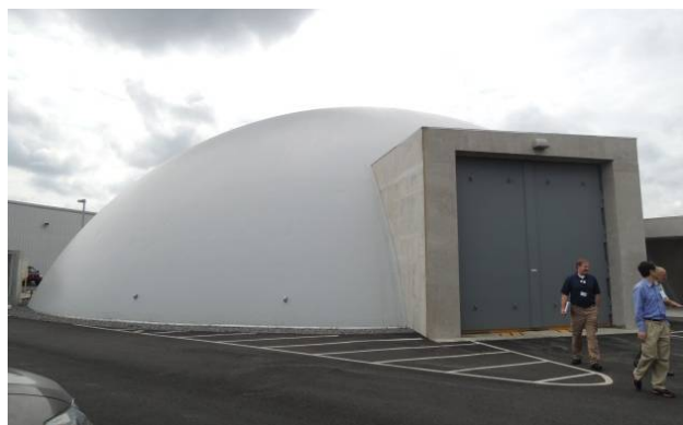
圖六 救援設備儲存設施外觀
