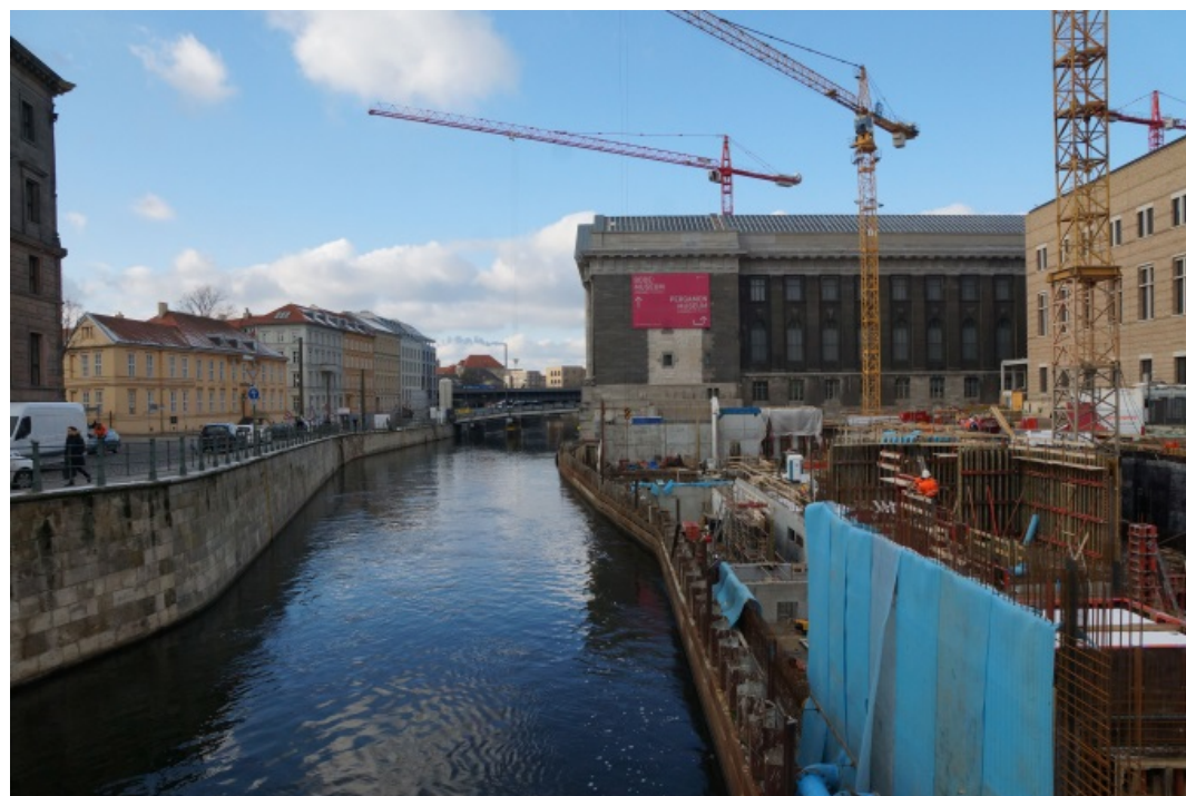
Kupfergraben 運河東側的工地。
