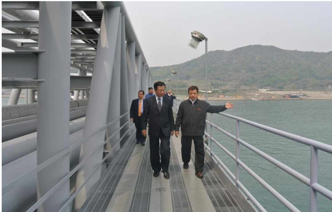
OKYC 人員向林董事長說明棧橋碼頭設備
