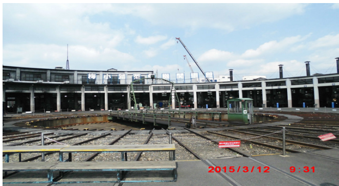
圖 3.3-12 蒸汽機車之扇形陳列車庫與機關車轉盤
