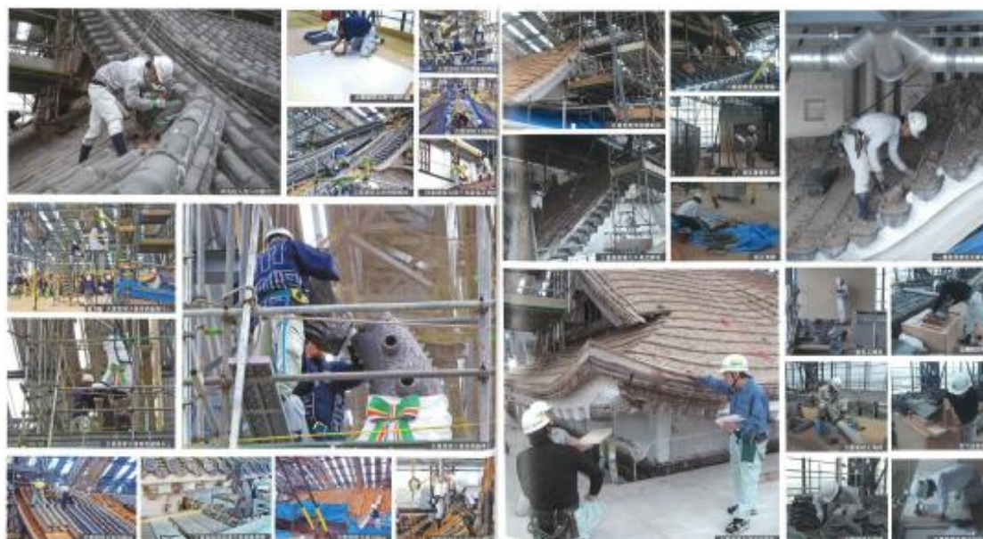
圖3-32：工作人員於不受外界打擾且安全的工作環境下進行施工
