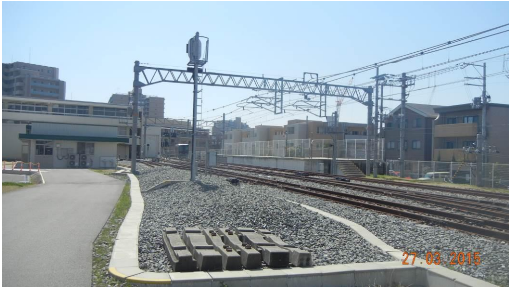
圖3-47：實習軌道、電車線及號誌設備等
