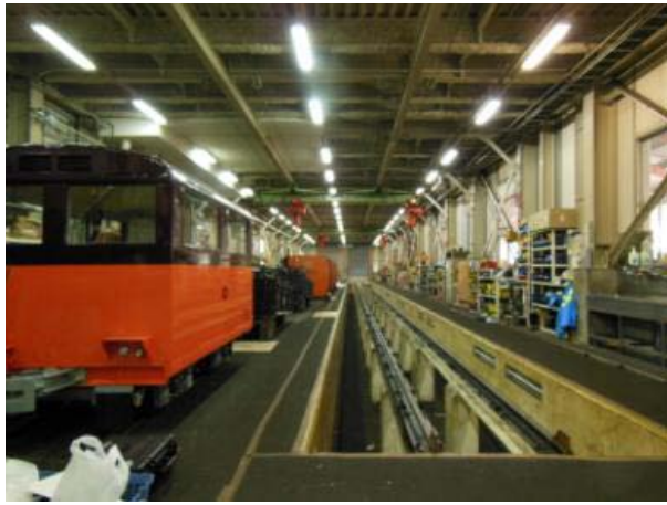
照片 3.17 黑鐵修理工廠整齊乾淨
