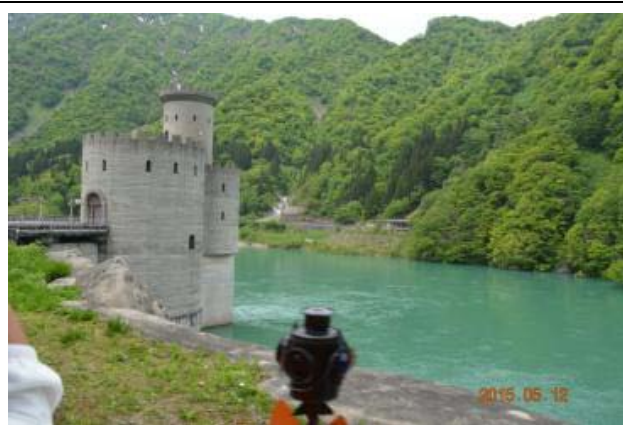
照片 3.39 新柳河源發電廠
