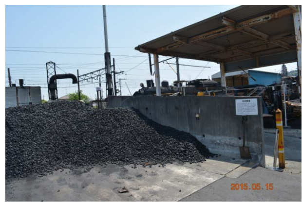
照片 6.40 堆置整齊的燃煤堆置場
