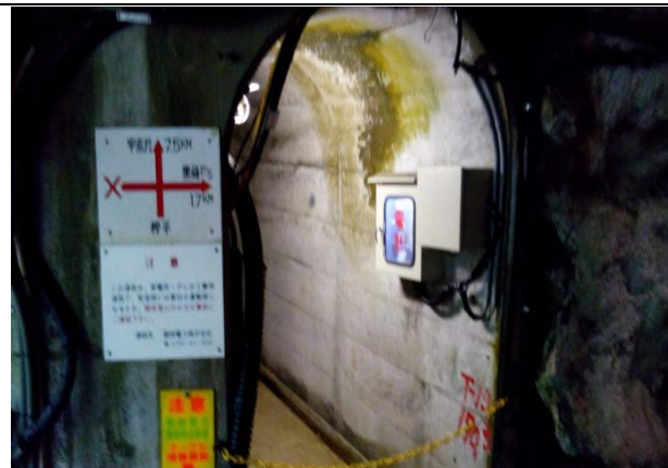
照片 3.44 大雪封山時工作人員步行之隧道
