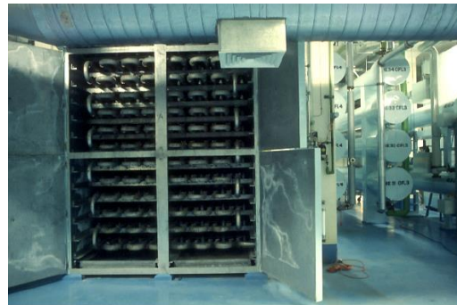
圖二、Continuous Flow System 的冷卻系統。
