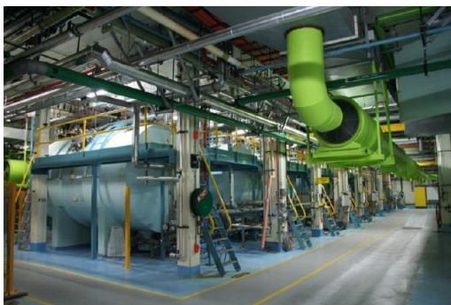
圖三、AAHL Batch System 污水處理系統。
