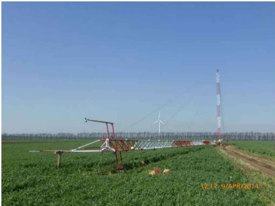
圖 十一：可水平傾倒之氣象塔架構
