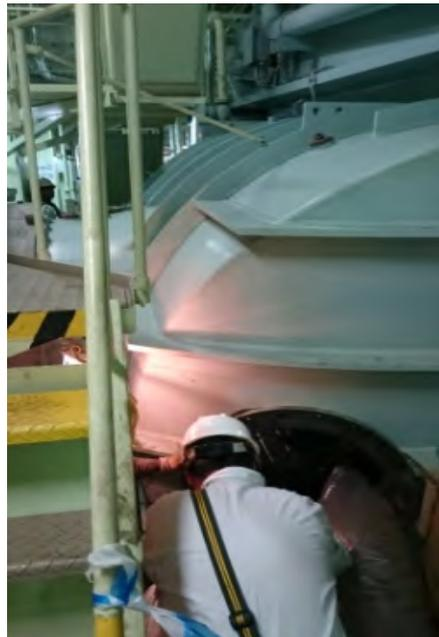
原廠技師用肥皂水進行冷卻銅管末端的氣密試驗，檢查是否有漏氣冒泡。
