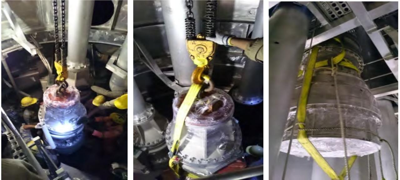
吊出前，Cargo pump以保鮮膜層層包覆，避免外來之灰塵泥沙沾染。
