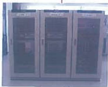
為系統核心的中央處理器裝置通常以控制/待命模式的二元系統,當控制模式的中央處理裝置故障時,待命模式的中央處理裝置將自動轉移到控制模式,持續系統功能.
