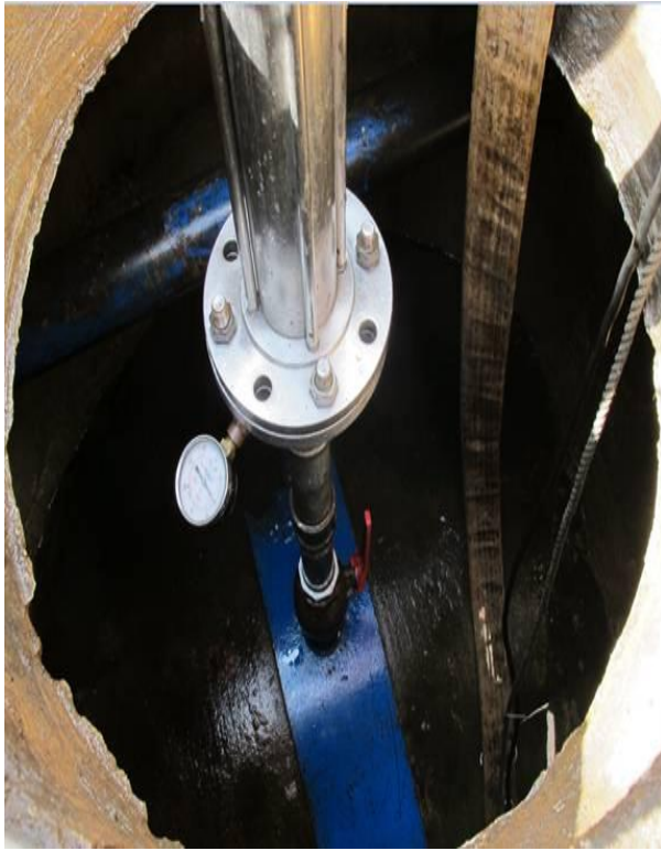
圖 8 Sahara 測漏現場觀摩-幹管鑿開洞口及勘測裝置
