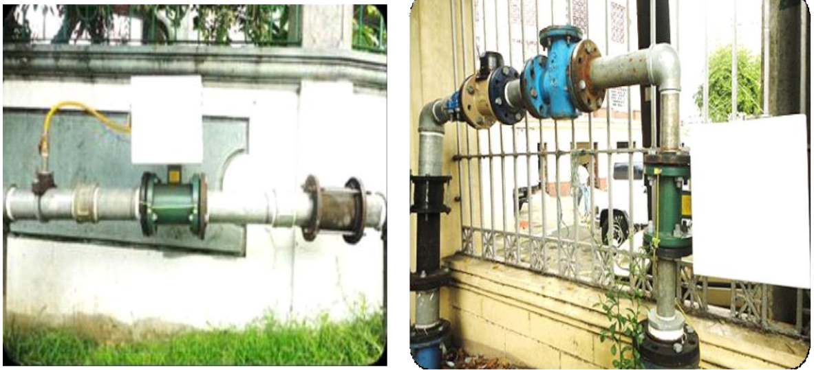
圖 4 大表採用電磁式水量計
