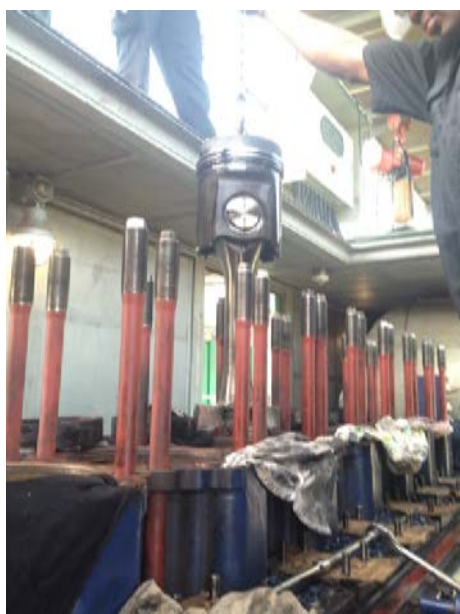
圖 3. 活塞連桿拆吊。
