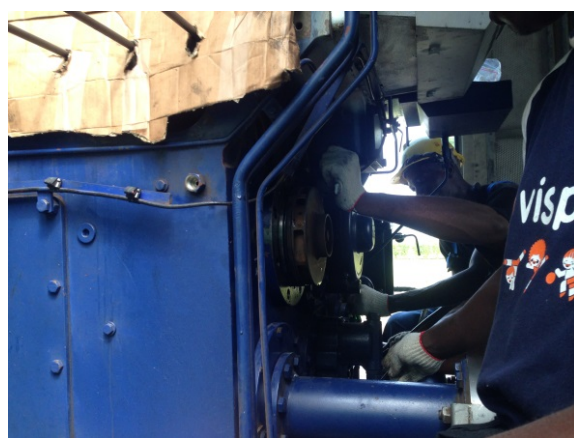
圖 18. 冷卻水泵回裝。
