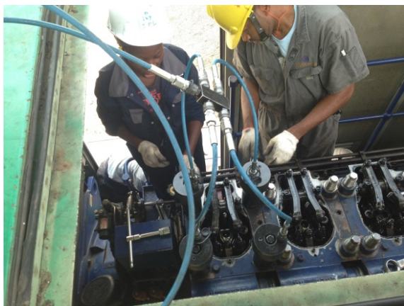
圖 1. 缸頭螺栓拆卸。
