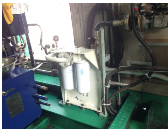
圖 16. 加裝燃油過濾器。
