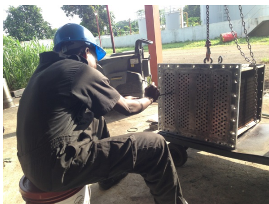
圖 5. 空氣冷卻器清理。
