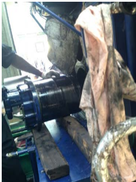
圖 1. 潤滑油泵拆解。
