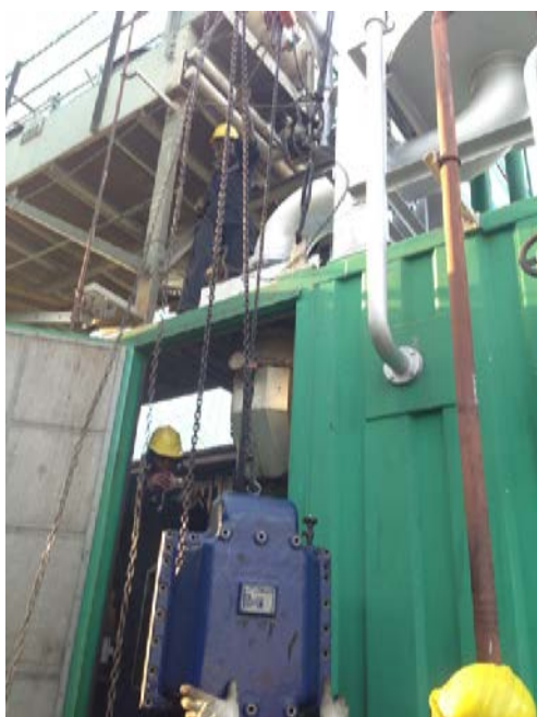
圖 5. 空氣冷卻器拆吊。
