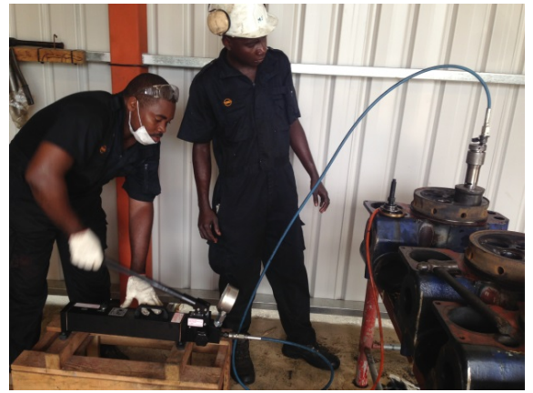
圖 8. 進/排氣閥座拆除。
