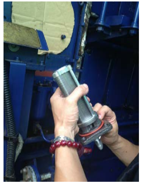
圖 8. 燃油過濾器更換。
