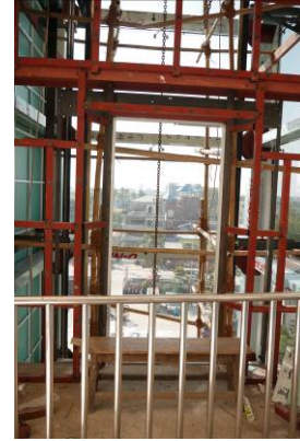
孔教(東區)學校正在興建電梯
