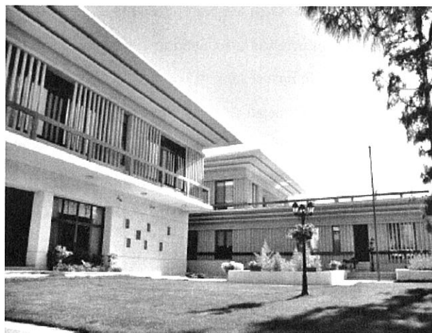
駐約旦代表處全貌
