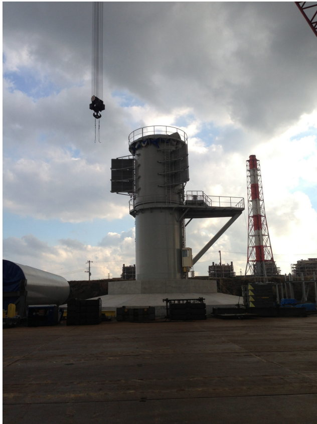
圖 5、5MW 示範機建置
