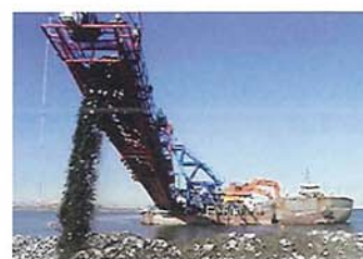
作業船による揚土状況
