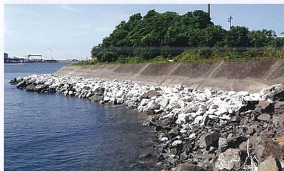
護岸根固め用の石材として天然石同等品と評価され、フロンティアロックが使用されました。
