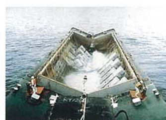
底開バージ船での投入状況
