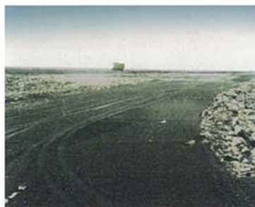
場内走行用道路 (東京都 中央防波堤)
