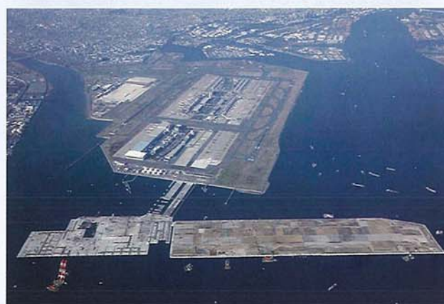
地盤材としてフロンティアストーンが使用された東京国際空港D滑走路建設外工事
