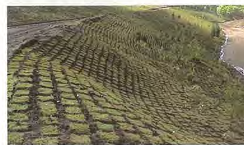
斜面安定と緑化のために植えられた芝生(手前)と樹木(奥)
