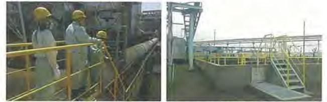
集塵機東側の連絡通路
