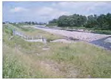
施工後6ヶ月経過
