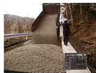
路盤材施工状況
