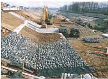
須川護岸工事 (山形県蔵王)
