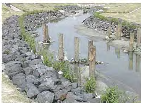
施工直後 (H18年3月)
