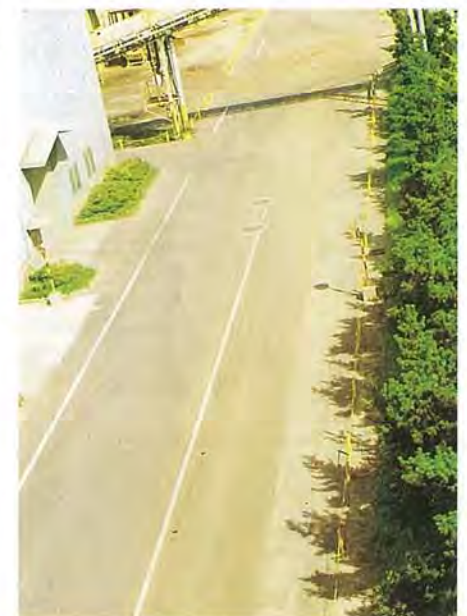
パムコスラグ路盤材を使用した当社構内試験道路
