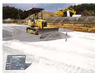
道路舗装工事
