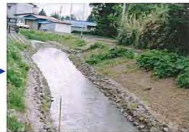
施工後2ヶ月経過
