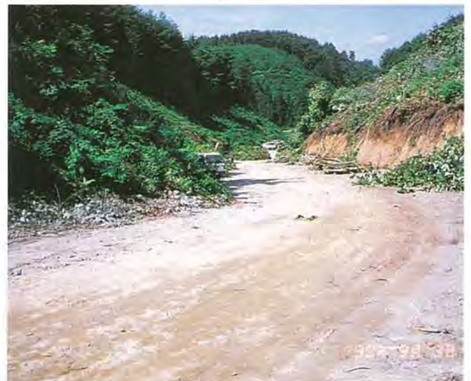
パムコスラグ覆土材を使用した仮設道路（青森県三戸郡）
