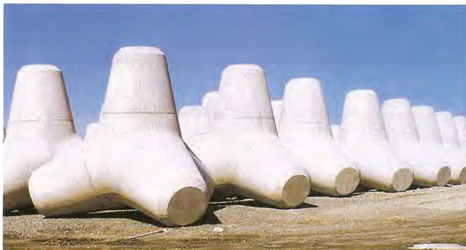
パムコサンド使用の重量消波ブロック (青森県六ヶ所港湾工事)
