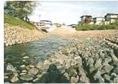
源長寺沢川多自然型護岸工事 (山形県)
