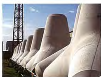
重量コンクリート消波ブロック
