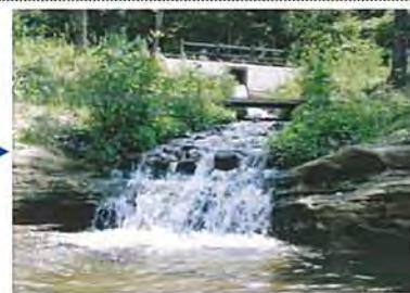
施工後5ヶ月経過
