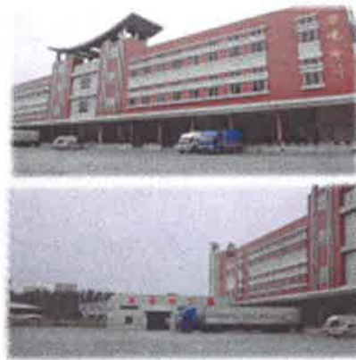
8.4 冷凍庫和水產加工區
