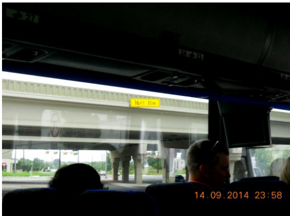
圖99 高速公路高架橋下限高標誌
